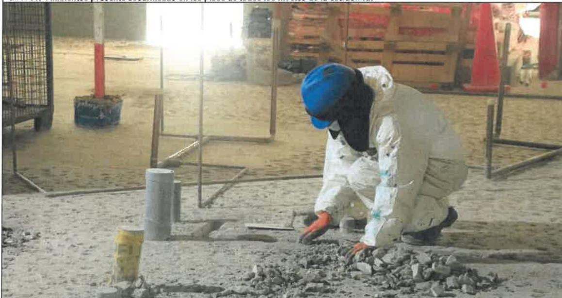
IMG. 02.- Proceso de escarificado
