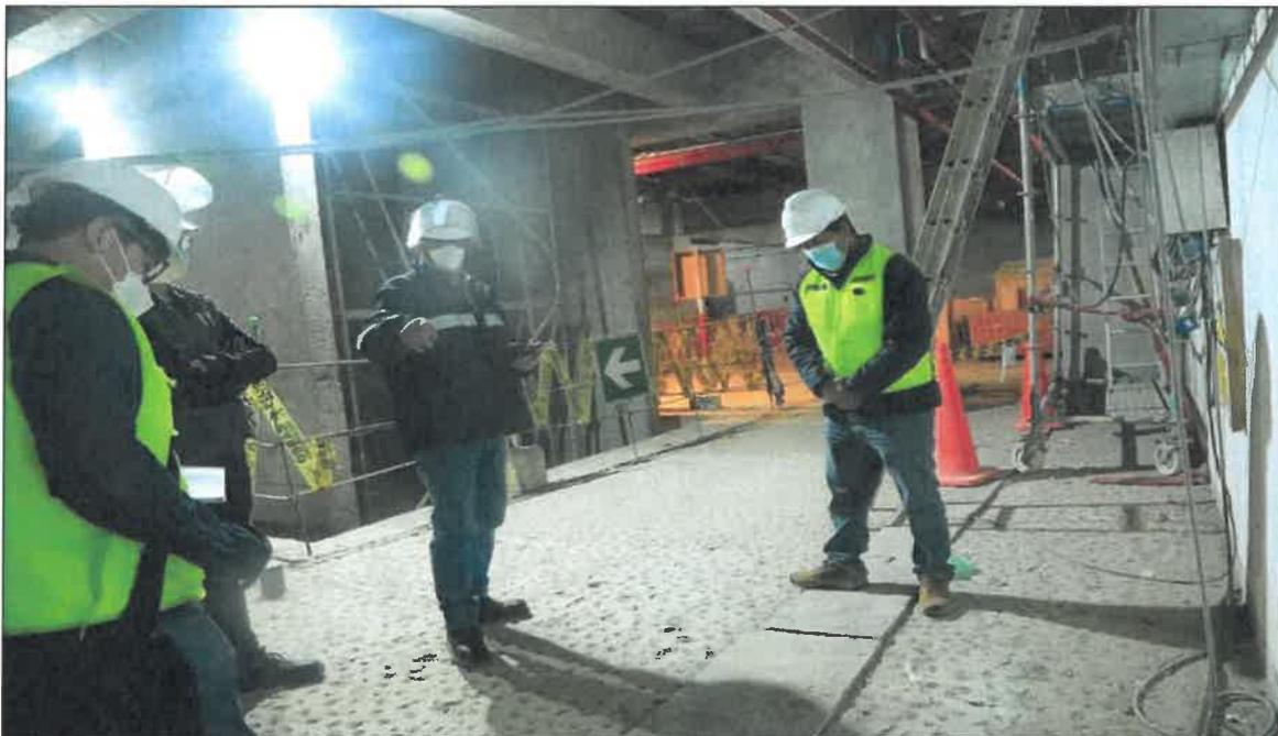
IMG. 01.- Ambientes presenta escarificado en los pisos de todos los niveles de la estructura.
