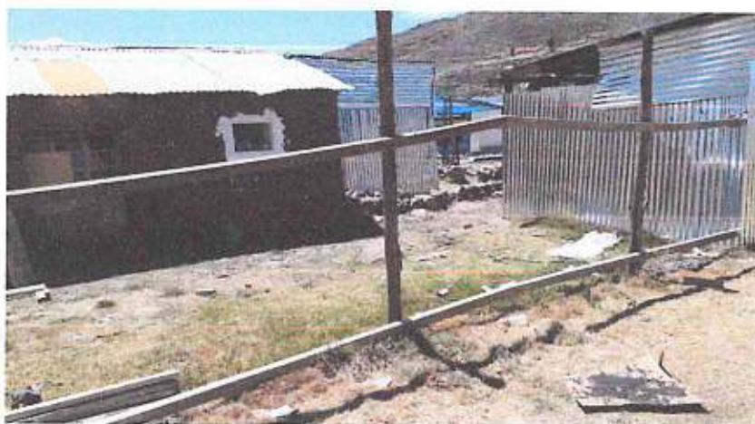
01.09.06.01 DESMONTAJE DE ESTRUCTURAS TEMPORALES
