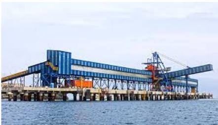
Las operaciones de embarque de concentrado de mineral se realizan desde el parque de almacenamiento con capacidad para 45 mil TM a través de una faja transportadora con capacidad instalada de mil TM/Hr. Para movilizar contenedores llenos y vacíos se cuenta con grúas móviles tipo reach stackers.
