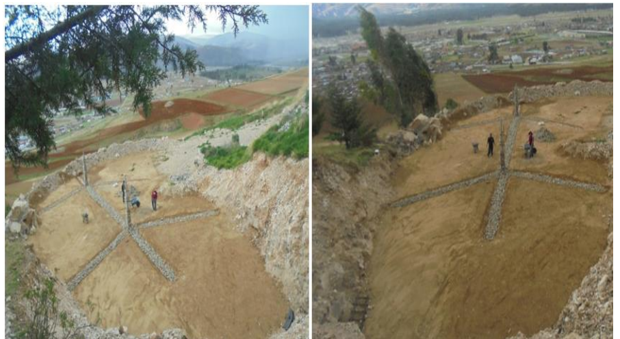
Figura 34 HABILITACIÓN DE LA PLATAFORMA DEL ÁREA DE DISPOSICIÓN FINAL DE RESIDUOS SÓLIDOS
