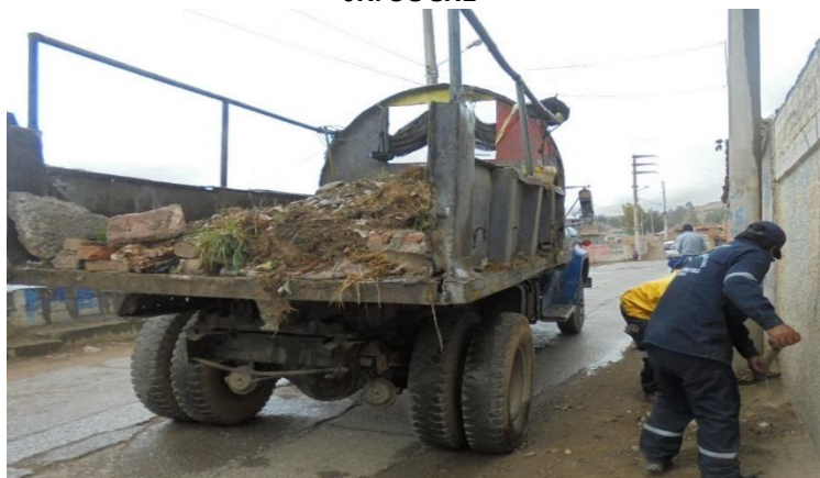
Figura 26 JORNADA DE RETIRO DE DESMONTE DE LA 1° CUADRA DEL JR. SUCRE
