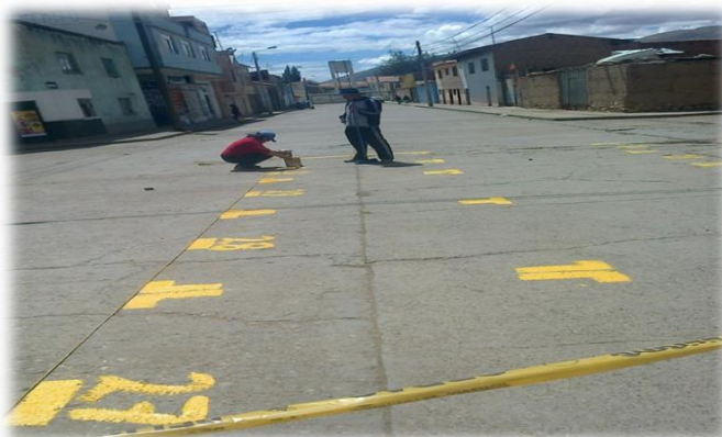
Figura 47 REPINTADO DE CUADRAS DEL BARRIO EL PORVENIR- 2015
