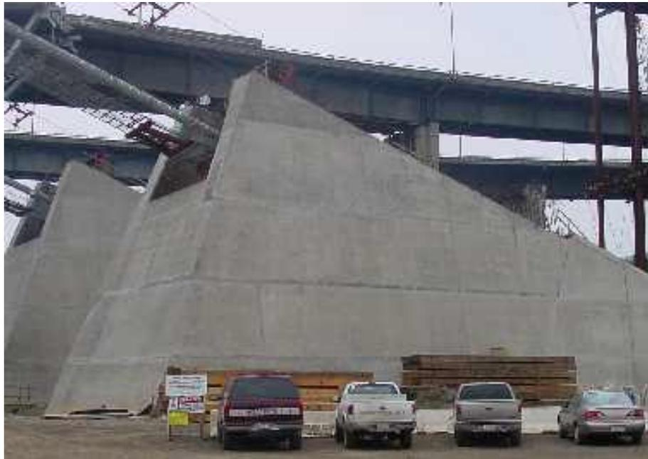
Figura 5: Estructura masiva vaciada en varias secciones [9].
