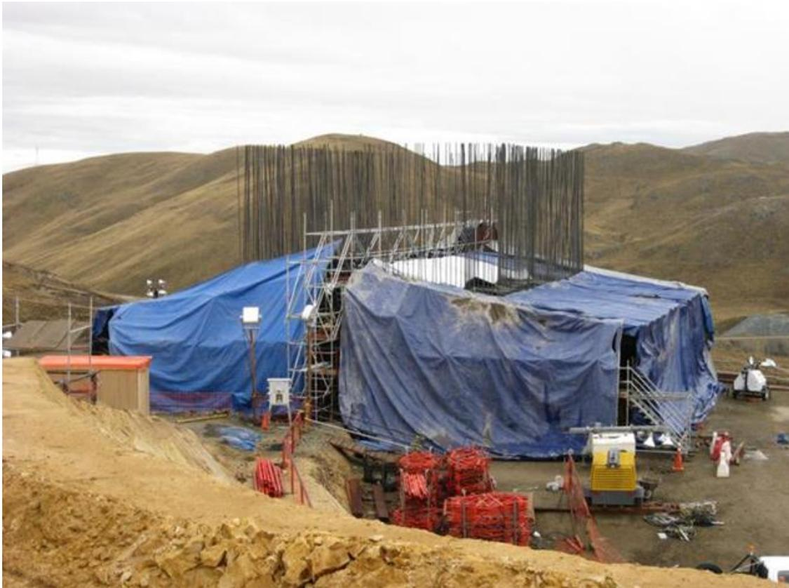
*Figura 9: Microclima instalado en vaciado de concreto masivo*
