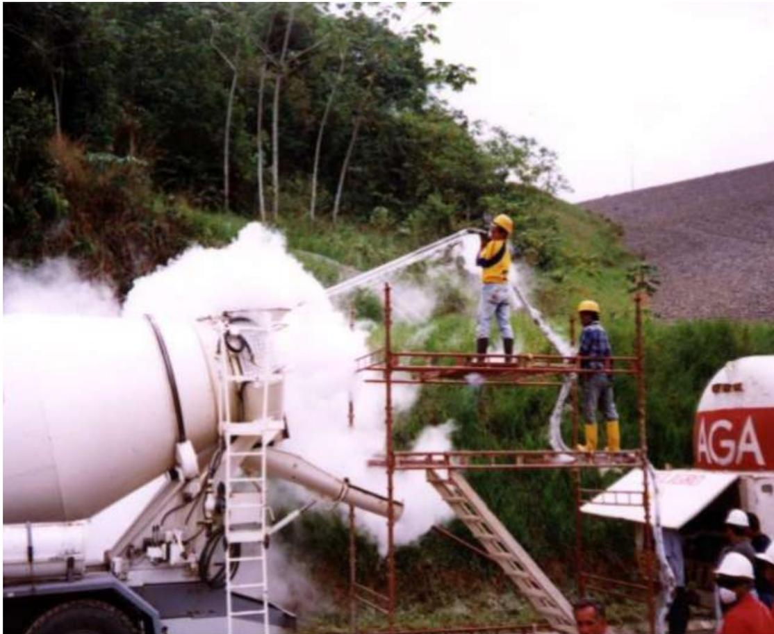
*Figura 4: Enfriamiento del concreto utilizando nitrógeno líquido (Fuente: Internet - ARGOS).*
