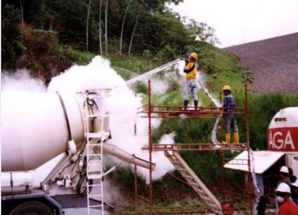
Figura 10: Enfriamiento del concreto utilizando nitrógeno líquido (Fuente: Internet - ARGOS).
