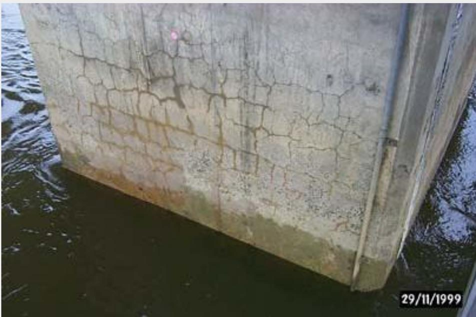
*Figura 5: Fisuras producidas por DEF en Pilar de Puente [20]*
