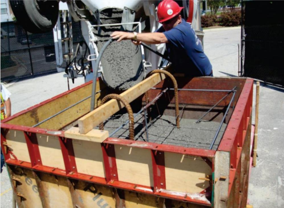
*Figura 17: Vaciado de bloque experimental de concreto [18].*
