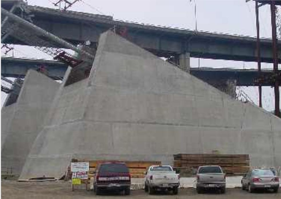
Figura 11: Estructura masiva vaciada en varias secciones [25].
