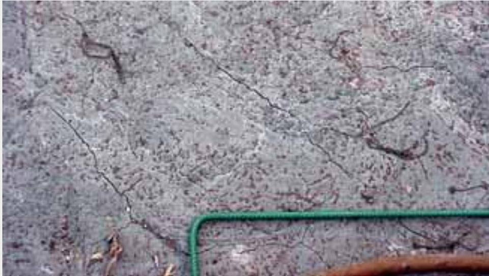
*Figura 1: Ejemplo de agrietamiento térmico severo en la superficie superior de una cimentación [16]*
