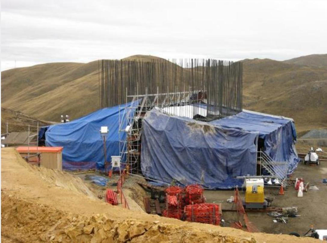
*Figura 15: Microclima instalado en vaciado de concreto masivo*
