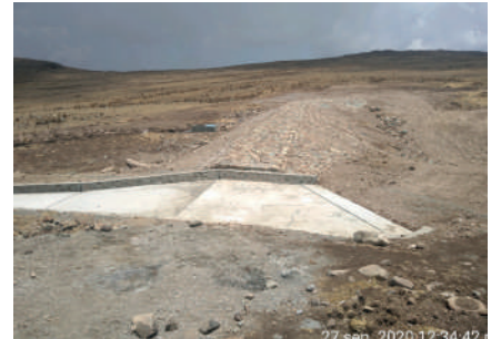
Departamento: Ancash Pukarapampa - Dique culminado
