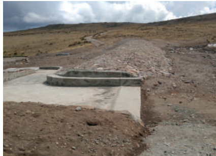
Departamento: Ancash Quilhuacocha - Dique culminado
