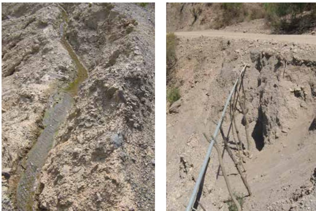
*Canal de riego en tierra y sin diseño adecuado (izquierda) y línea de conducción frágil por diseño inadecuado (derecha), ambas expuestas a la ocurrencia de probable deslizamiento.*
