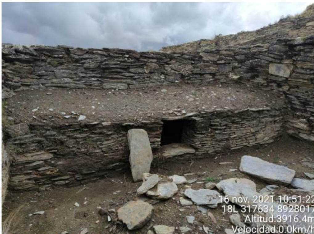
Foto N° 12.- Fotografía a detalle de la estructura arquitectónica del sitio arqueológico de Curipunta, donde se observa la intervención, evidenciada por el mortero de barro fresco, el cual se diferencia de lo prehispánico.
