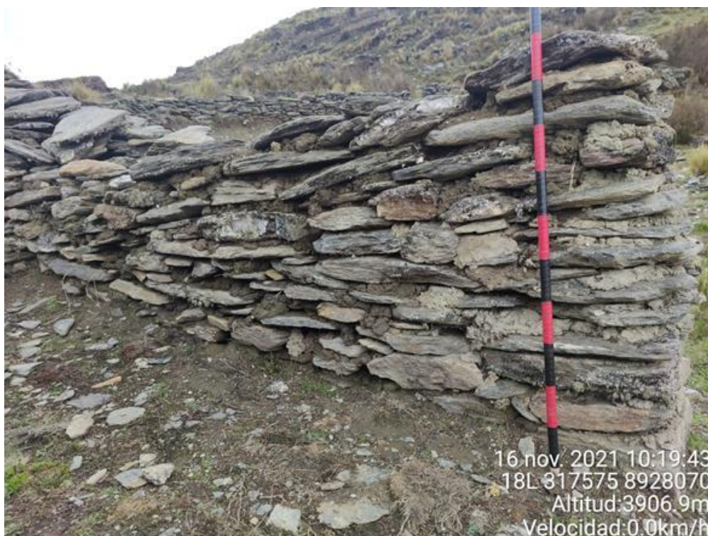
Foto N° 02.- Fotografía a detalle de la estructura arquitectónica del sitio arqueológico de Curipunta, donde se observa la intervención realizada, mortero de barro fresco.
