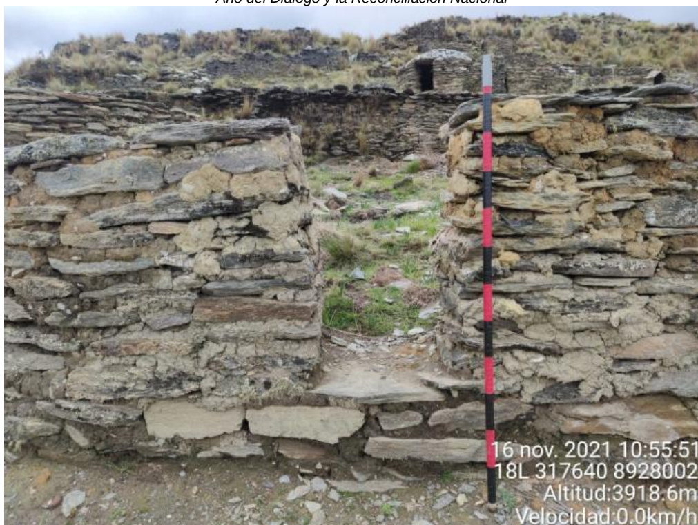
Foto N° 06.- Fotografía a detalle de la estructura arquitectónica del sitio arqueológico de Curipunta, donde se observa la intervención, evidenciada por el mortero de barro fresco, el cual se diferencia de lo prehispánico.
