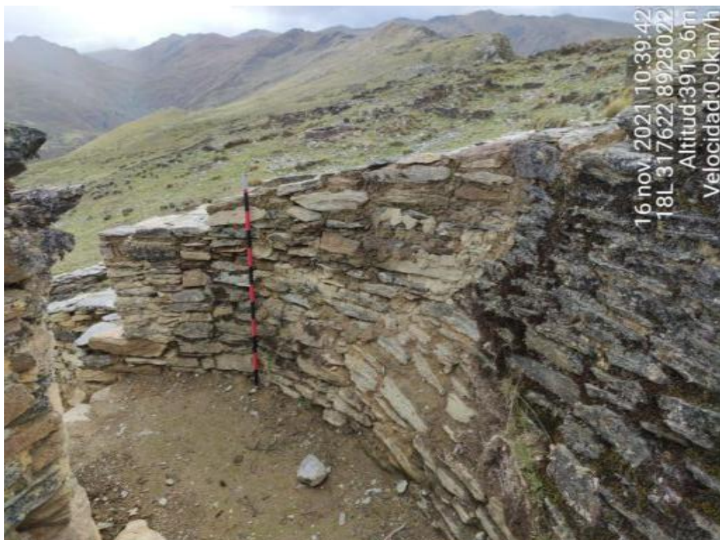
Foto N° 22.- Fotografía a detalle de la estructura arquitectónica del sitio arqueológico de Curipunta, donde se observa la intervención, evidenciada por el mortero de barro fresco, el cual se diferencia de lo prehispánico.
