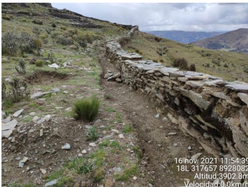
Foto N° 18.- Fotografía a detalle de la estructura arquitectónica del sitio arqueológico de Curipunta, donde se observa la intervención, evidenciada por el mortero de barro fresco, el cual se diferencia de lo prehispánico. Asimismo, se observa la remoción del suelo colindante al muro.
