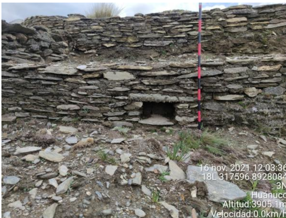
Foto N° 15.- Fotografía a detalle de la estructura arquitectónica del sitio arqueológico de Curipunta, donde se observa la intervención, evidenciada por el mortero de barro fresco, el cual se diferencia de lo prehispánico.
