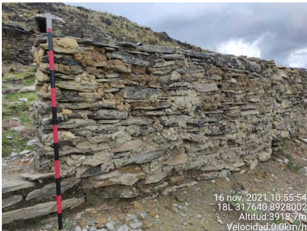
Foto N° 07.- Fotografía a detalle de la estructura arquitectónica del sitio arqueológico de Curipunta, donde se observa la intervención, evidenciada por el mortero de barro fresco, el cual se diferencia de lo prehispánico.
