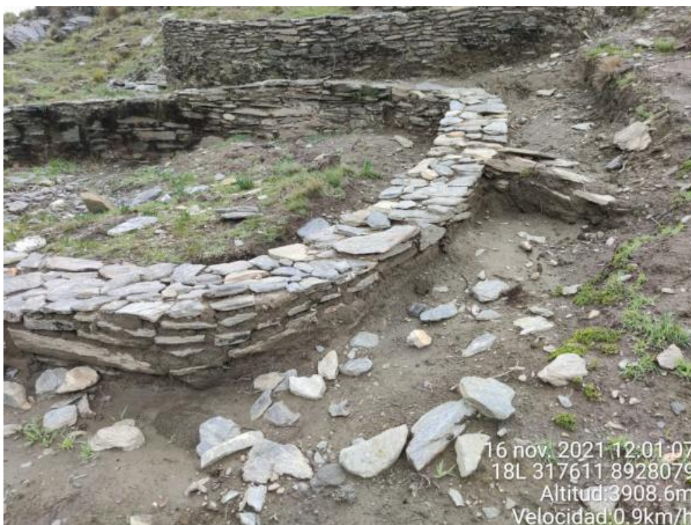
Foto N° 16.- Fotografía a detalle de la estructura arquitectónica del sitio arqueológico de Curipunta, donde se observa la intervención, evidenciada por el mortero de barro fresco, el cual se diferencia de lo prehispánico.
