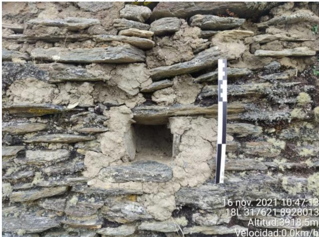
Foto N° 21.- Fotografía a detalle de la estructura arquitectónica del sitio arqueológico de Curipunta, donde se observa la intervención, evidenciada por el mortero de barro fresco, el cual se diferencia de lo prehispánico.
