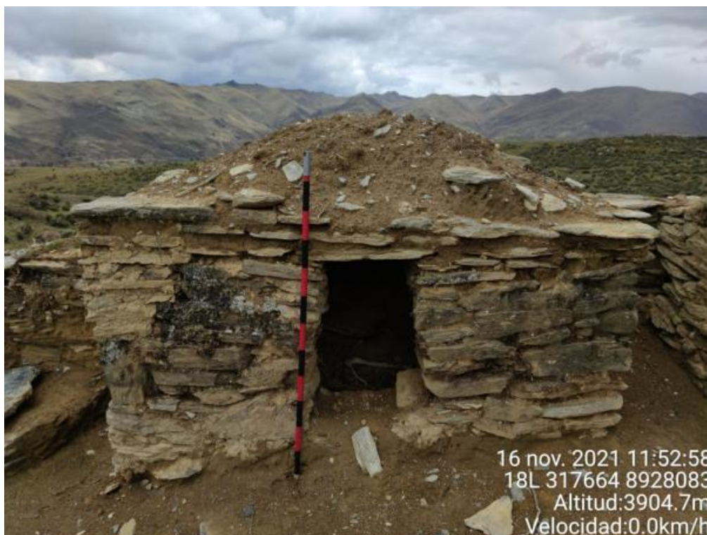
Foto N° 17.- Fotografía a detalle de la estructura arquitectónica del sitio arqueológico de Curipunta, donde se observa la intervención, evidenciada por el mortero de barro fresco, el cual se diferencia de lo prehispánico.
