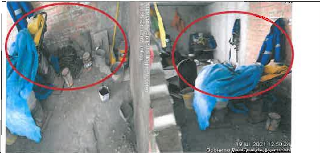
Almacenamiento inadecuado de materiales peligrosos y equipos de protección personal
