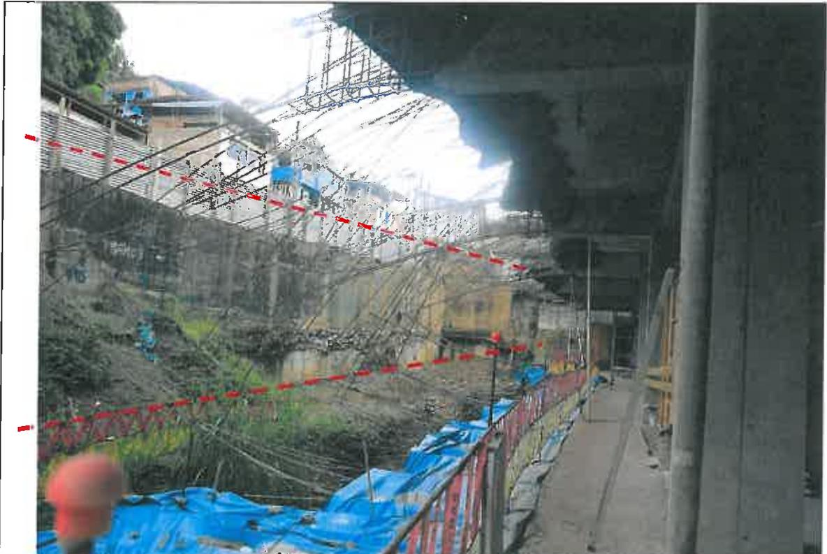
IMG. N°01.- Cerco perimétrico de concreto armado (existente) ubicado en la Av. Huanta. – Aceros expuestos a la intemperie.
