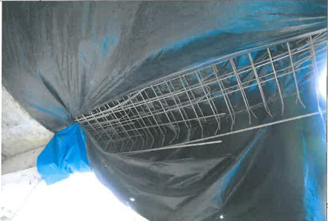
**IMG. N°03.- Se evidencia exposición de los aceros en losas y vigas en todos los niveles de los bloques
