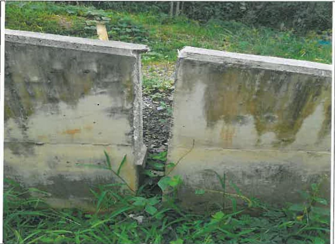
IMG. N°03.- Se evidencia separación de muros de concreto.
