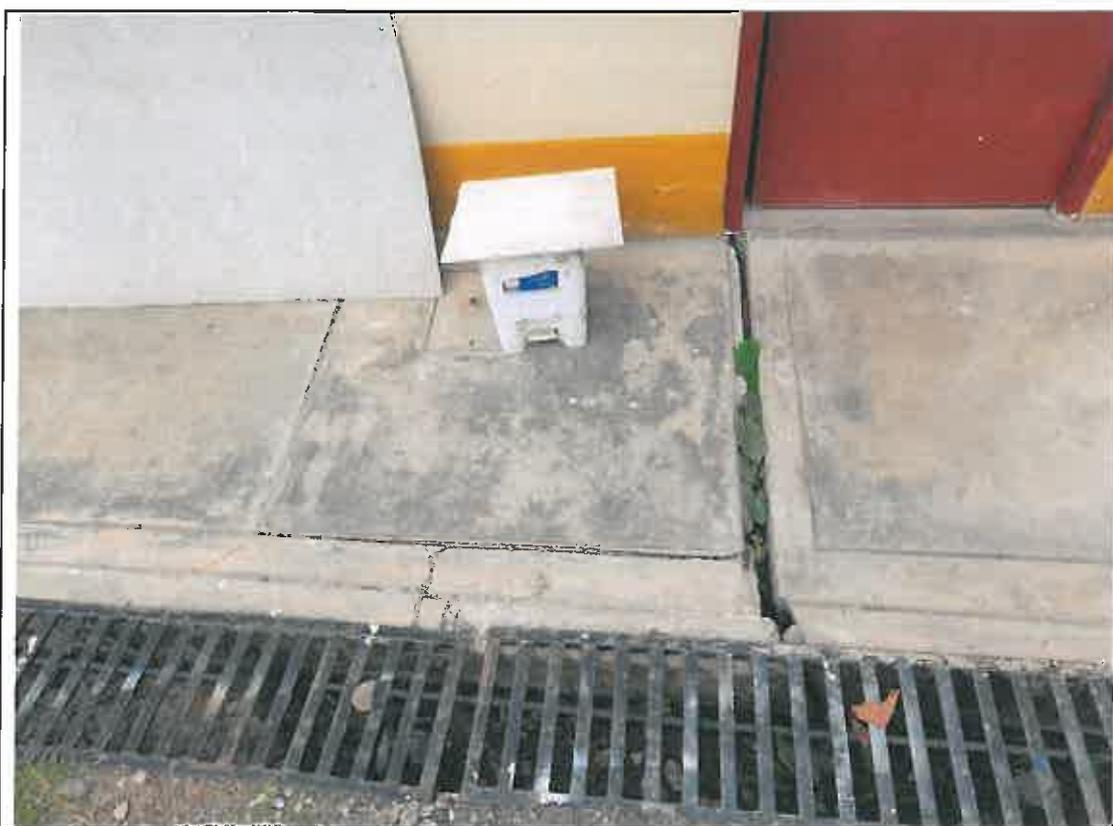
IMG. N°03.- Se evidencia desnivel en la vereda a consecuencia del asentamiento del suelo.
