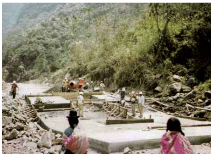
Construcción de badenes para canalizar las quebradas
