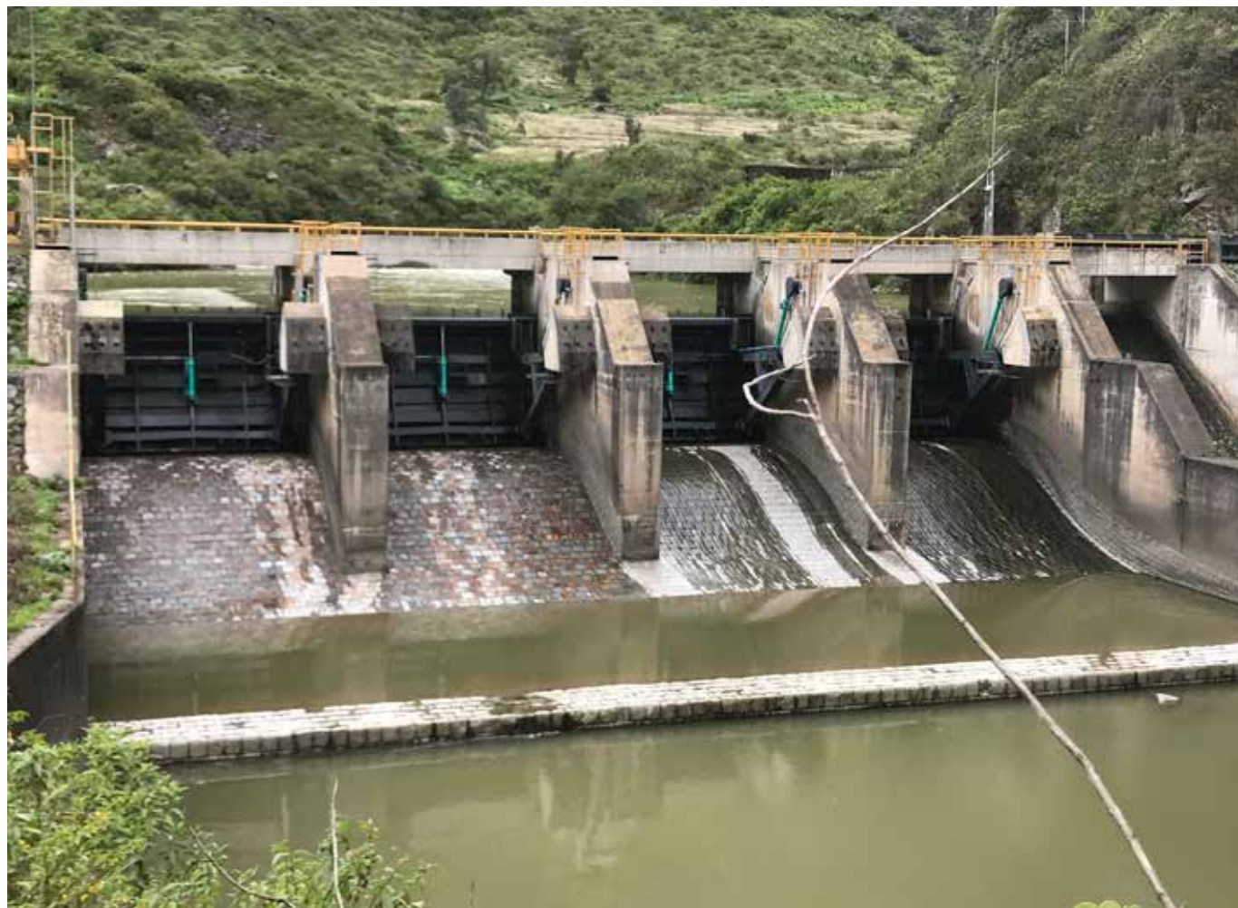
Mantenimiento de la presa derivadora
