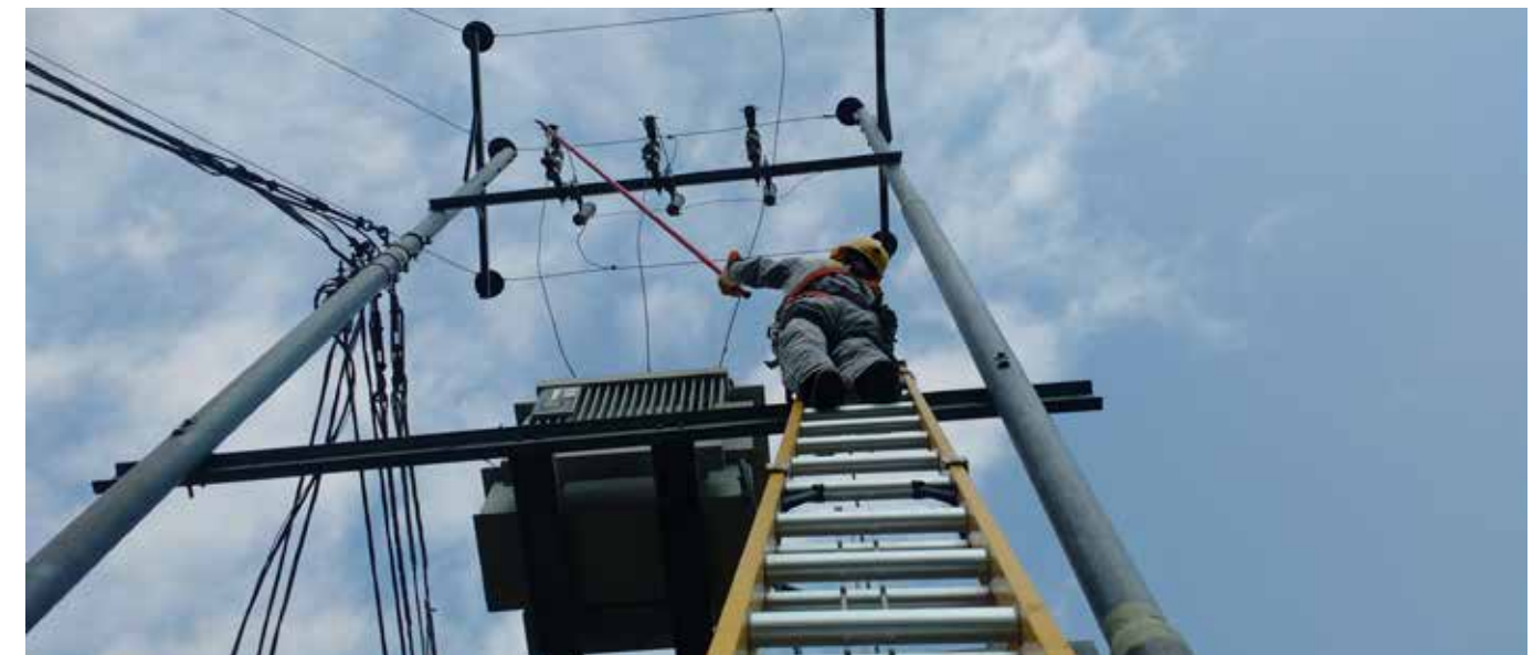
Mantenimiento de LT y SE
