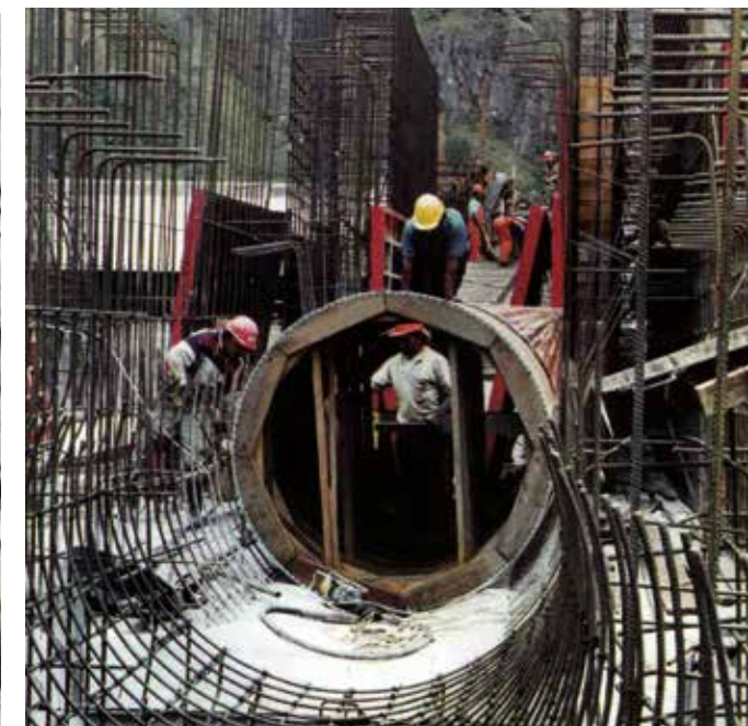
Obras de Cabecera: Construcción del Conduto Cubierto
