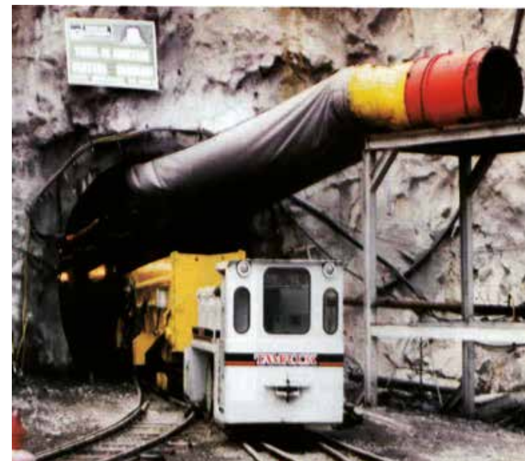
Salida de la Ventana de Urahusi: Equipo de Acarreo Haggloader y Locomotora
