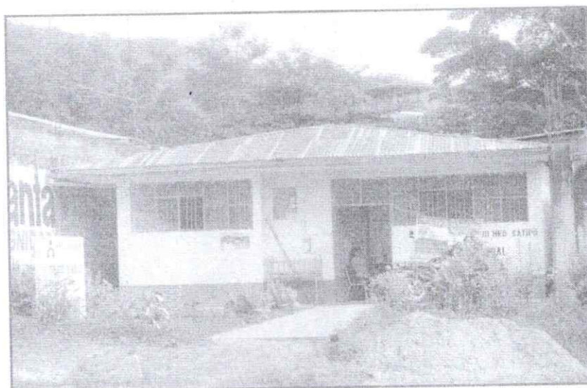
Foto N° 2. Puesto de Salud
