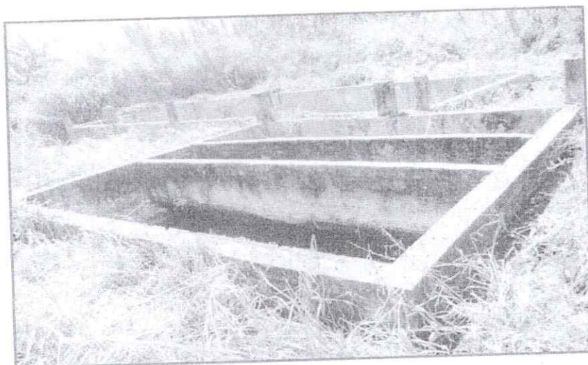
Foto N° 10. Tanque Imhoff
