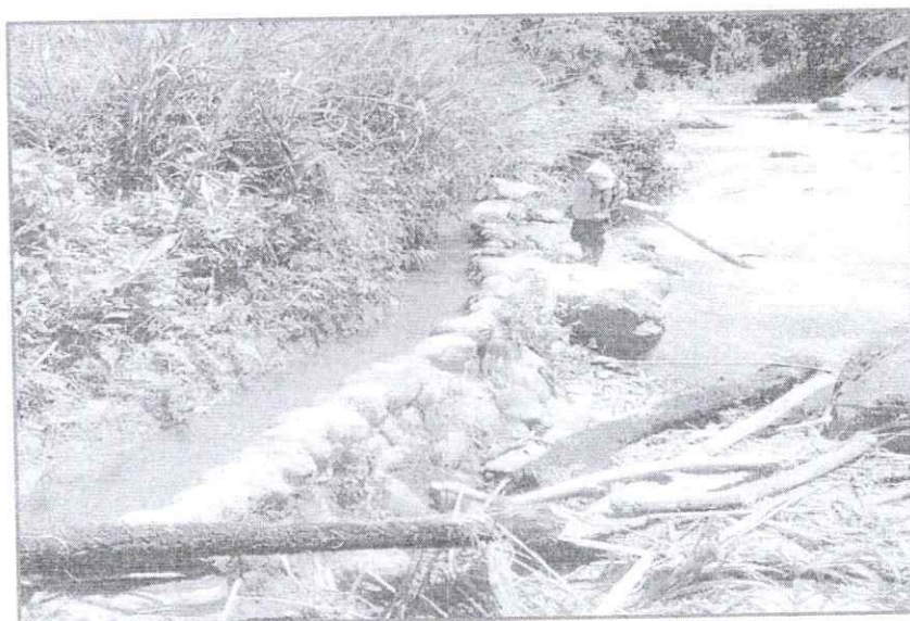
Foto N° 5. Rio Teoría y Captación Existente
