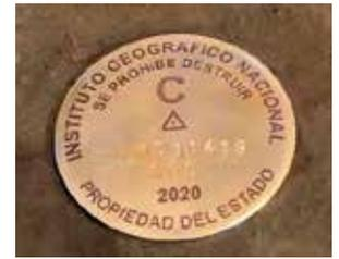
Figura 4: Punto de Control Terrestre Horizontal - Vertical N°1.
