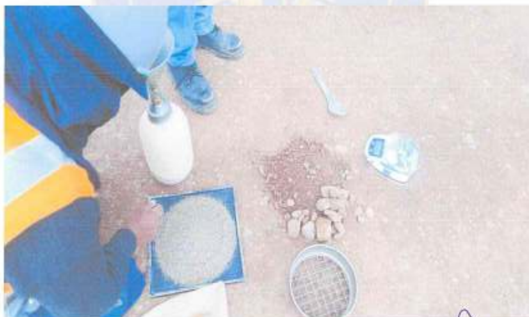
KM.4+250 LADO IZQUIERDO CAPA SEPTIMA DENSIDAD DE CAMPO MARGEN DERECHO
