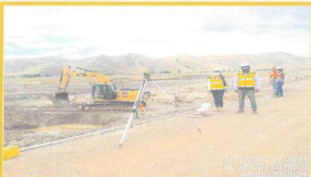
FOTO - 35 LA FOTO MUESTRA: CONTROL DE NIVELACION DEL TALUD DEL ENROCADO Y CONFORMACION DE UÑA, EN EL MARGEN IZQUERDO.
