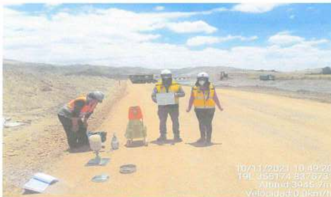
KM. 6+400 LADO DERECHO SEXTA CAPA, DENSIDAD DE CAMPO IN SITU, MARGEN IZQUIERDO
