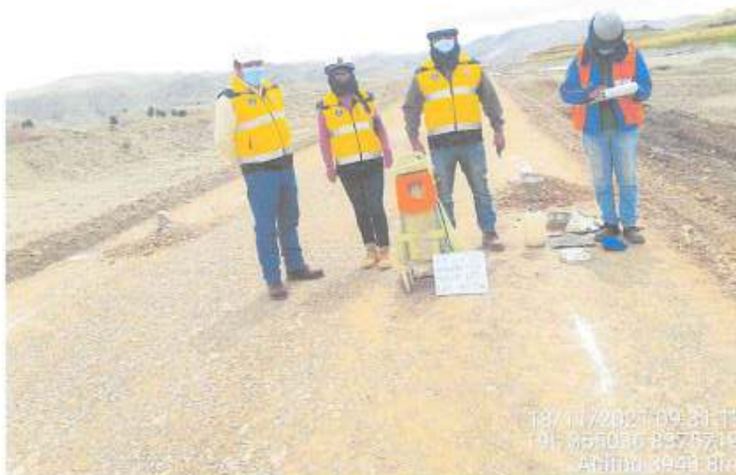
KM. 4+374 LADO IZQ. CAPA OCTAVA, CONTROL DE COMPACTACIÓN POR EL METODO CONO DE ARENA MARGEN DERECHO
