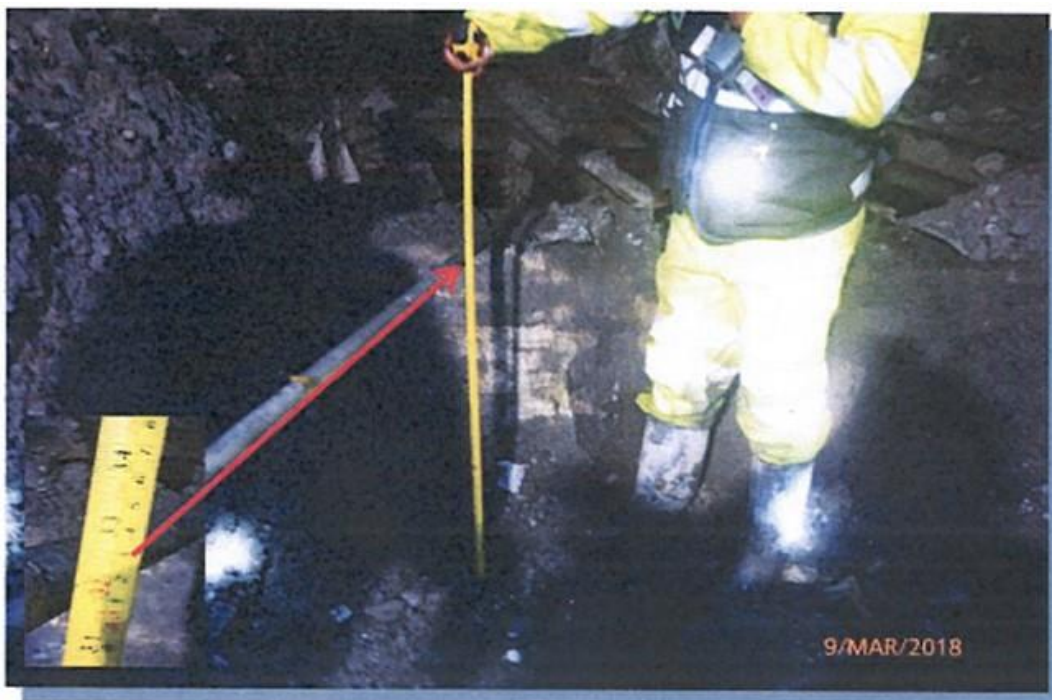
FOTO N° 64: Vista de la medida de 0.83 m del muro de seguridad de concreto, en el echadero de desmonte del Nv 1020 en la mina Central.
