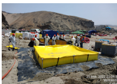
Playa Costa Azul, acciones de almacenamiento primario de los residuos sólidos y líquidos generados por la limpieza del área afectada.
