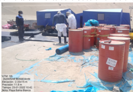
Instalación de geomembrana en Playa Bahía Blanca.
