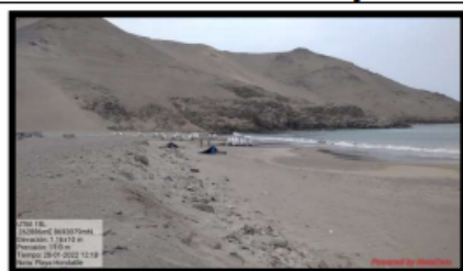
Playa Hondable (Santa Rosa) – Trabajos de limpieza en la franja de playa
