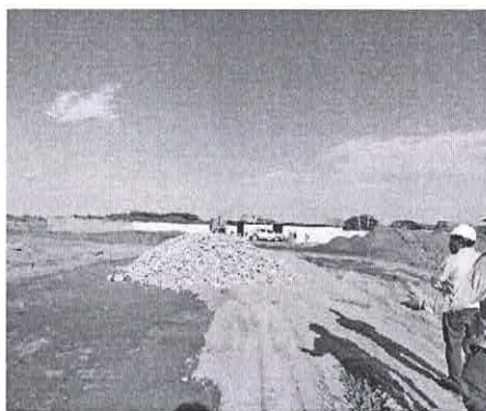
OBRA. Se inició a fines de enero, pero se suspendió por covid-19.
