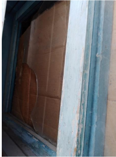
Foto 10. Condición de la ventana del almacén del Laboratorio de Evaluación de cocinas mejoradas
