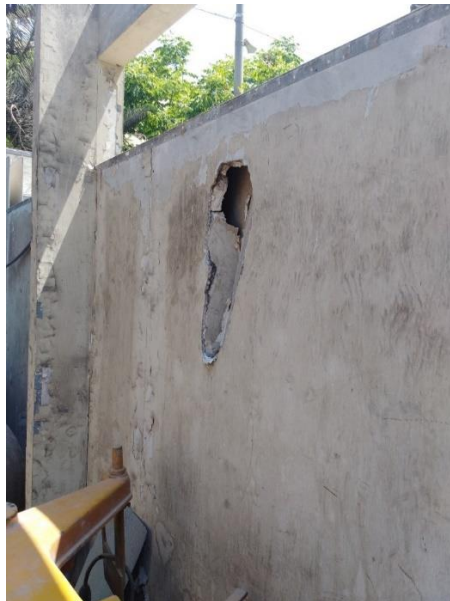
Foto 6. Condiciones de la pared del ambiente de pruebas
