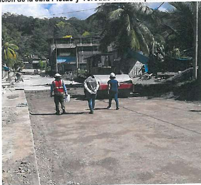
Imagen N° 7 Ejecución de la obra Pistas y Veredas en Principales Calles de Sivia
