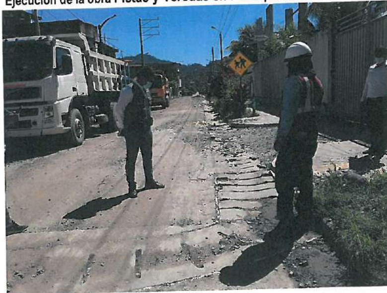
Imagen N° 11 Ejecución de la obra Pistas y Veredas en Principales Calles de Sivia
