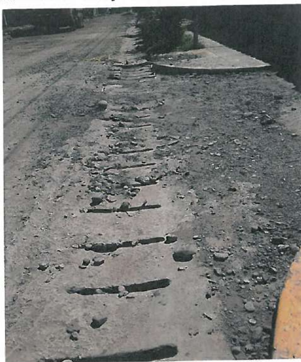
Imagen N° 12 Ejecución de la obra Pistas y Veredas en Principales Calles de Sivia
