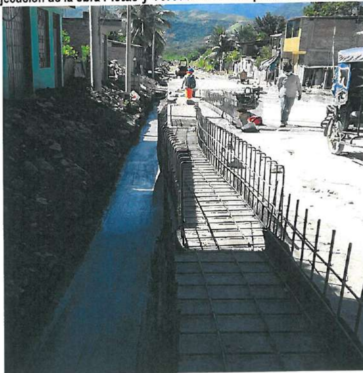
Imágenes N° 8 Ejecución de la obra Pistas y Veredas en Principales Calles de Sivia
