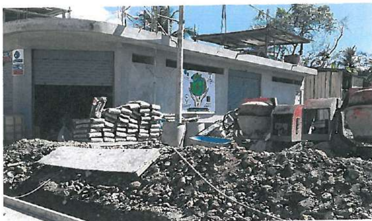
Imagen N° 9 Ejecución de la obra Pistas y Veredas en Principales Calles de Sivia
