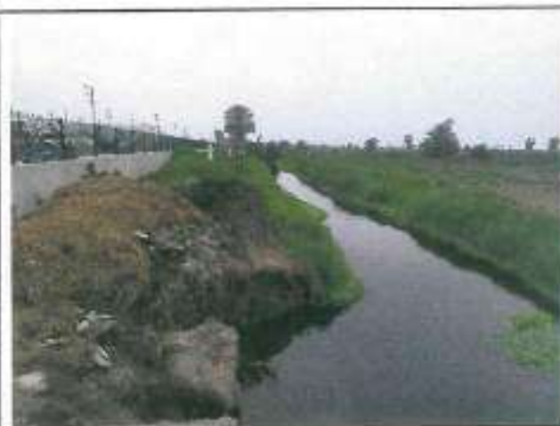
Foto N° 14: Validación del Canal Defensores 1.
