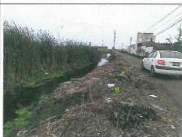
Foto N° 04: Validación del Canal Horticultores 2.
