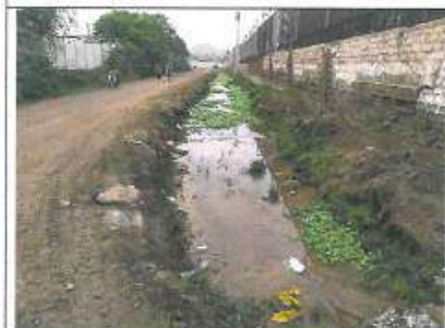
Foto N° 03: Validación del Canal Horticultores 1.
