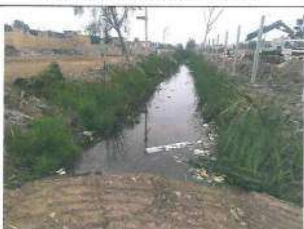
Foto N° 12: Validación del Canal Sangradero.
