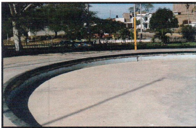
Infraestructura de pileta en mal estado, sin funcionamiento, carente de iluminación y revestimiento de pileta deteriorado de Parque Bolognesi
