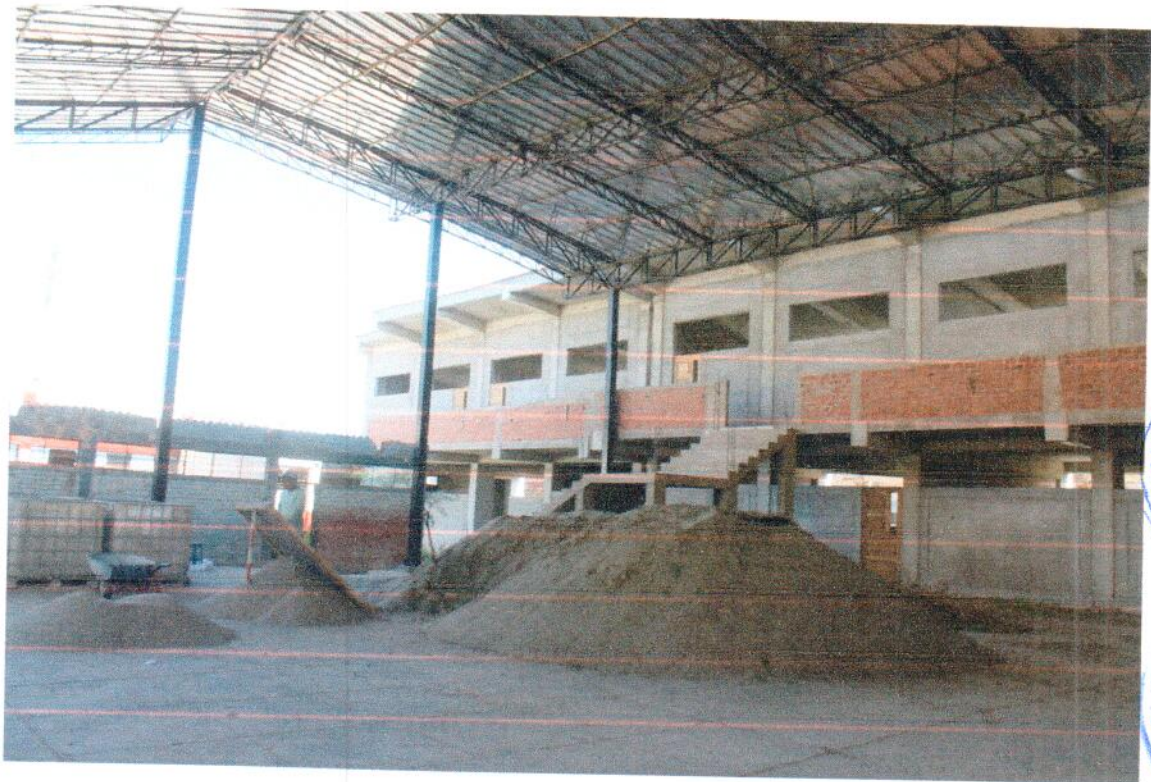
PIP EN EJECUCION: MEJORAMIENTO DEL SERVICIO EDUCATIVO EN LA IE 15029 SANTA TERESA DE JESUS EN EL A.H. SANTA TERESITA – SULLANA
