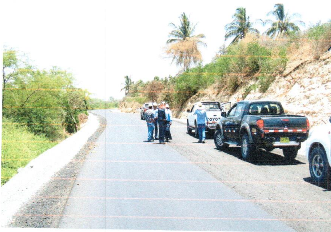
PIP EN EJECUCION: MEJORAMIENTO DE LA CARRETERA VECINAL DEL ALTO CHIRA DESDE BOQUERON DE NUÑEZ HASTA CHILACO - SULLANA
