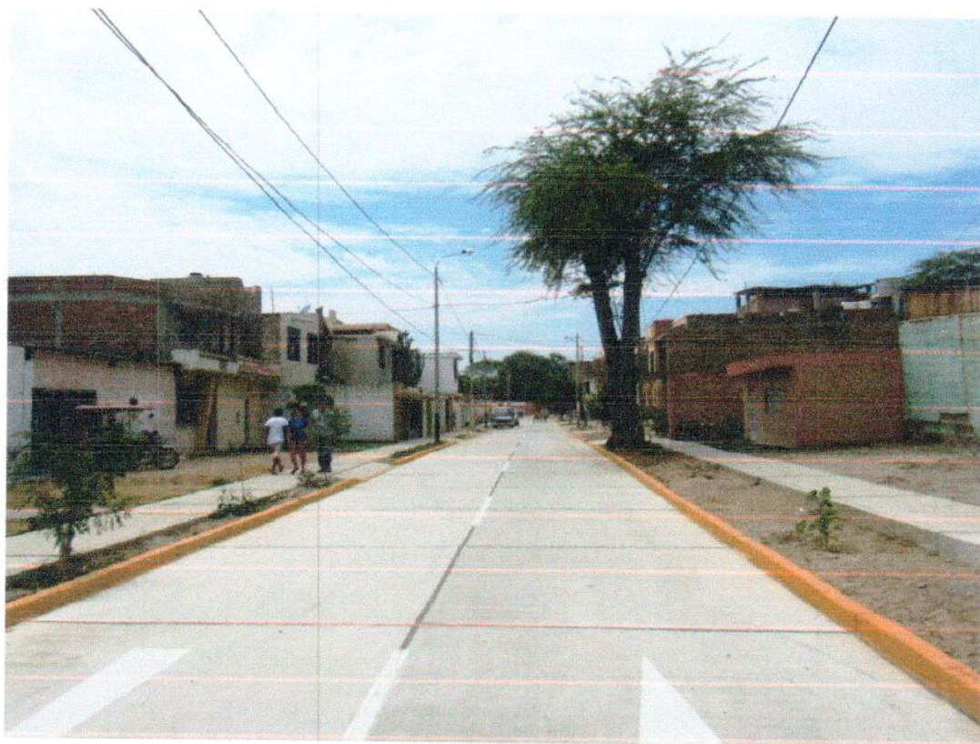
PIP A NIVEL DE OBRA: CONSTRUCCION DE PISTAS Y VEREDAS URB. SULLANA - SULLANA
