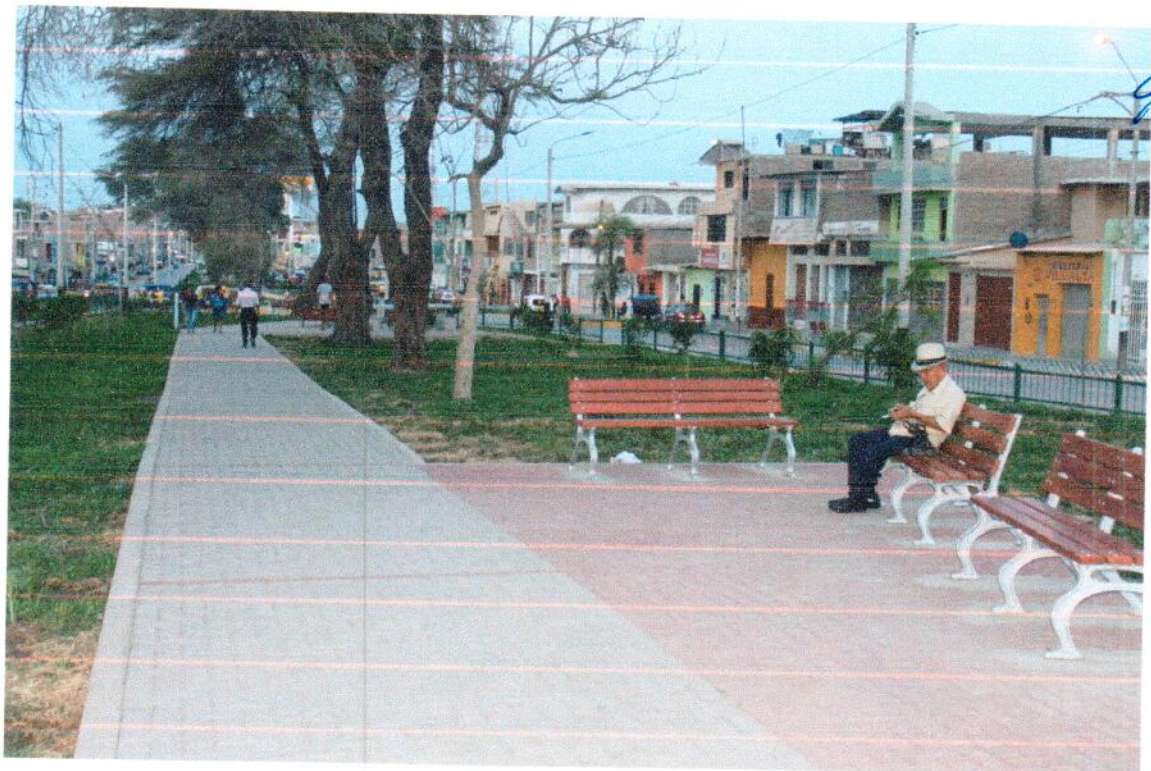
PIP A NIVEL DE OBRA: MEJORAMIENTO DE LA TRANSITABILIDAD VEHICULAR Y PEATONAL DE LA AV. JOSE LAMA - SULLANA
