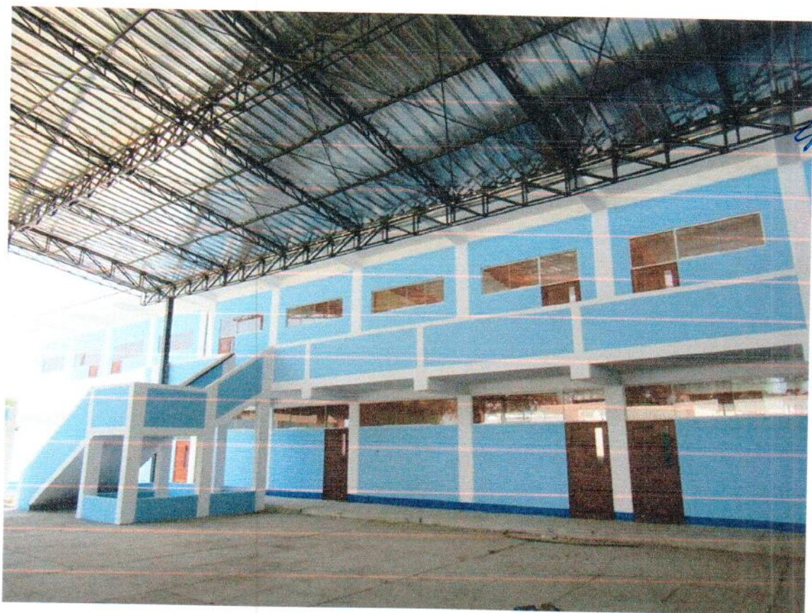
PIP A NIVEL DE OBRA: MEJORAMIENTO DEL SERVICIO EDUCATIVO EN LA IE 15029 SANTA TERESA DE JESUS EN EL A.H. SANTA TERESITA - SULLANA.
