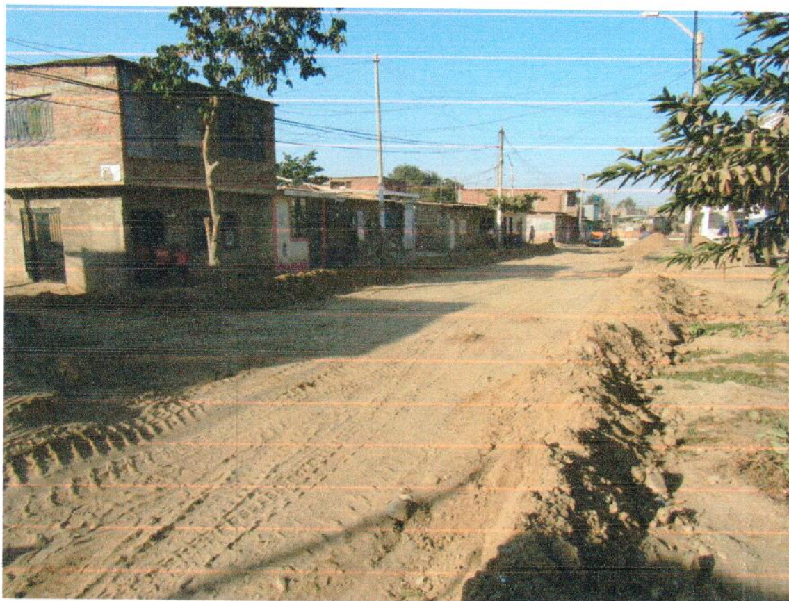
PIP EN EJECUCION: CONSTRUCCION DE PISTAS Y VEREDAS AA.HH. PILAR NORIS Y FCO. BOLOGNESI - SULLANA
