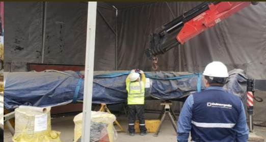
Supervisión del traslado del PLEM
