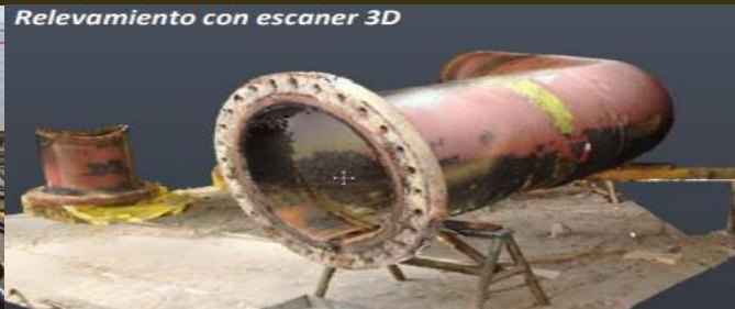
Relevamiento con escaner 3D
