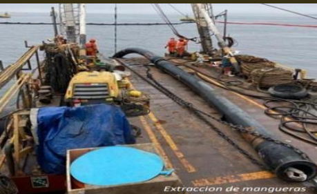
Extracción de mangueras
