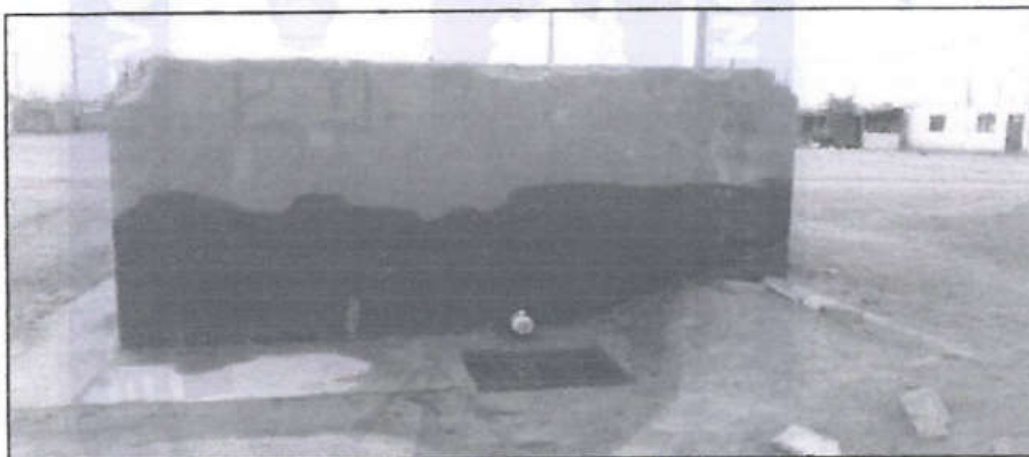
IMAGEN N° 5 FILTRACIONES DE AGUA EN MURO (PARTE INFERIOR) DE LADO POSTERIOR
