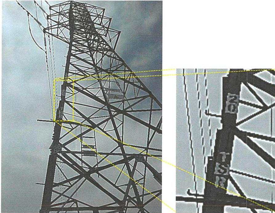
En la vista fotográfica de la izquierda se puede observar que la torre T20 se encuentra construida, incluyendo los conductores y aisladores correspondientes. En la vista de la derecha se aprecia en detalle la codificación de la torre.
