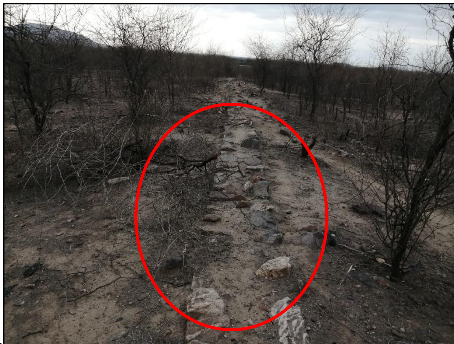
Muro Inca en el sector 1 de Piura La vieja, se observa la afectación debido al desmontaje del mismo
