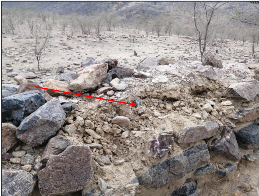
Otro muro Inca desmontado, muchas piedras han sido utilizadas para construcción de casas según los lugareños, se observa la afectación y el riesgo de colapso
