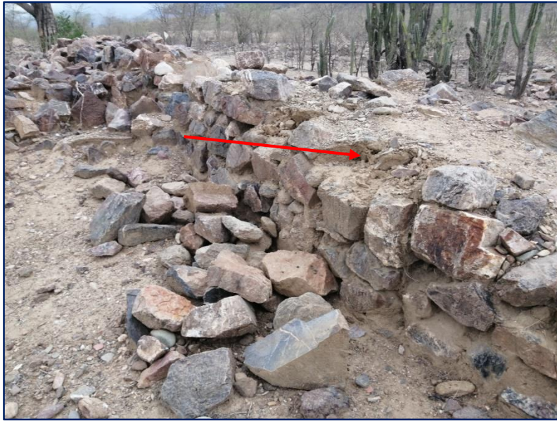
Muro inca desmontado donde señala la flecha, se observa el área afectada y amontonamiento de piedras caídas
