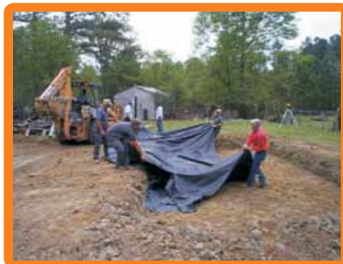
FIGURA N° 17. Primera fase de instalación del humedal A. Excavación de zanja; B. Instalación de la geomembrana
