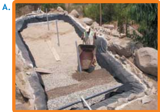
FIGURA N° 19. Segunda fase de instalación del humedal A. Colocación de los sustratos; B. Siembra de plantas.
