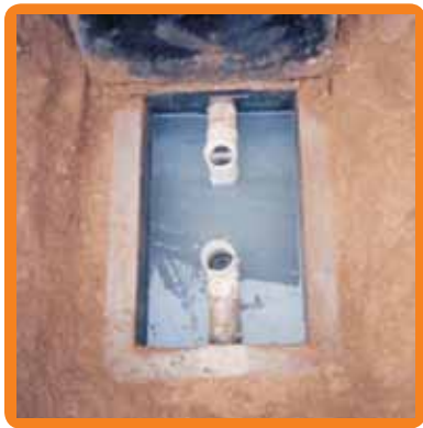
El agua gris pasa por una trampa de espumas y grasa
