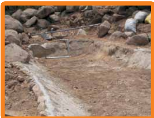
FIGURA N° 17. Primera fase de instalación del humedal A. Excavación de zanja; B. Instalación de la geomembrana
