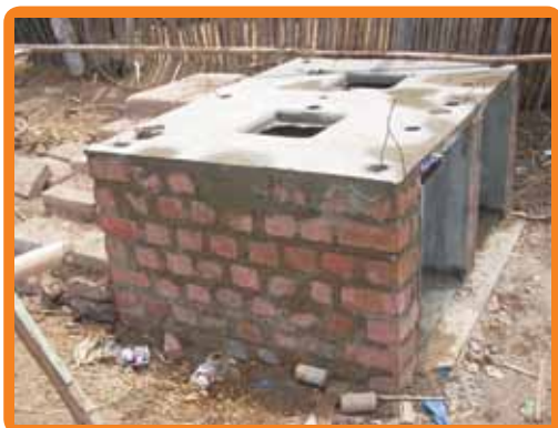
Dos cámaras con ladrillo revestido
