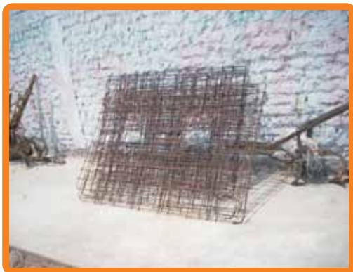
Parrilla de acero para losa
