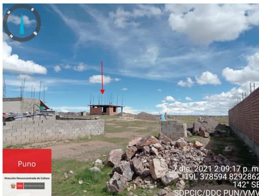
Construcción Informal de vivienda (2021).
