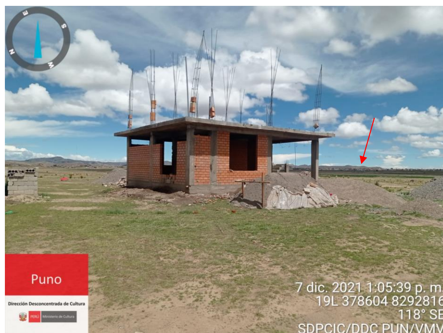
Construcción Informal de vivienda (2021).
