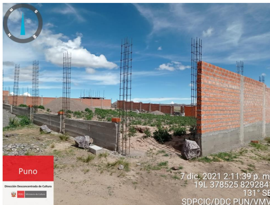
Construcción de cerco perimétrico (2021).
