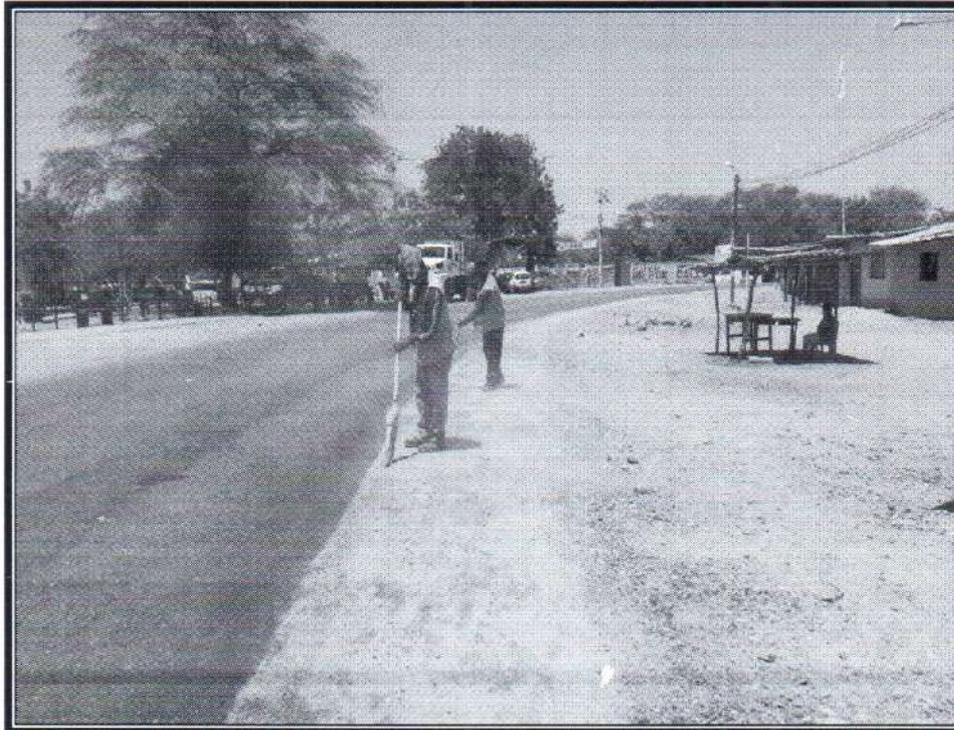
Toma N° 59: Barrido Manual de Berma previo a los trabajos de colocación de Slurry Seal
