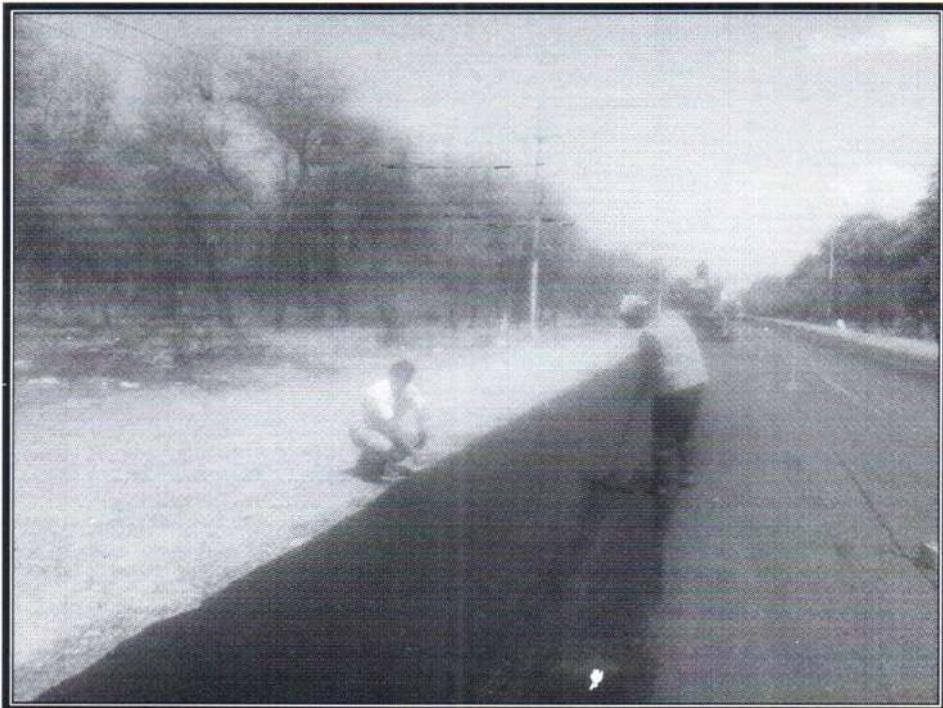
Toma N° 70: Supervisión verificando espesor colocado de Slurry Seal en Bermas.
