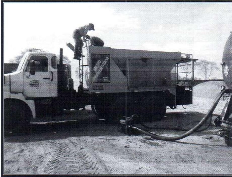
Toma N° 61: Preparación de Micropavimentadora previo a los trabajos de colocación de Slurry
