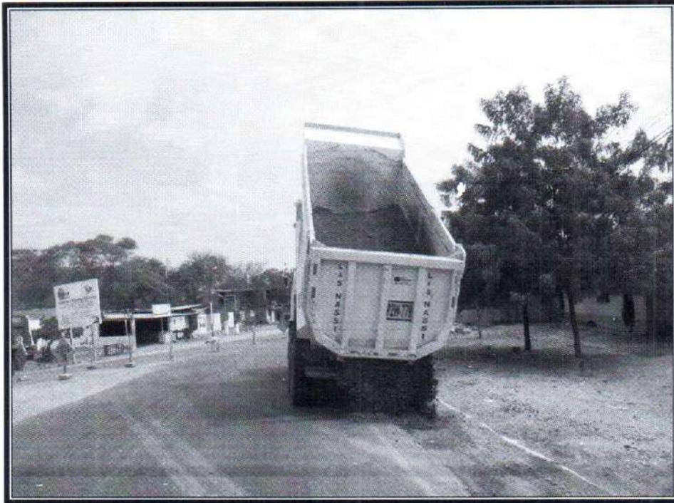
Toma N° 23: Suministro y Colocación de Material Granular en bermas de margen derecho
