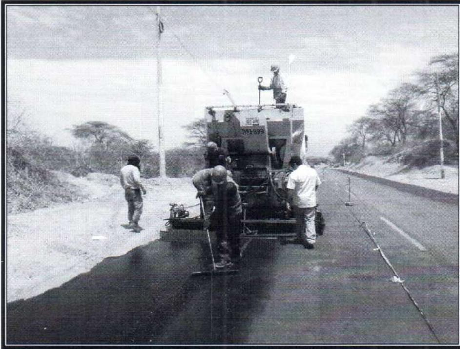
Toma N° 69: Supervisión verificando correcta colocación de Slurry Seal en Bermas.
