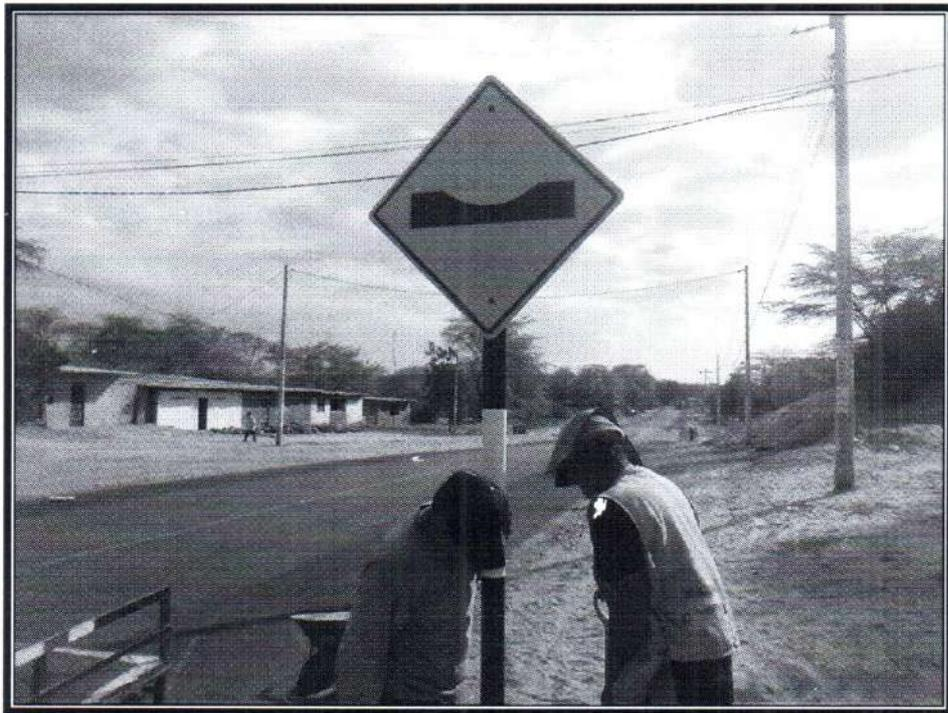
Toma N° 76: Instalación de poste de soporte y colocación de Señal Preventiva nueva.
