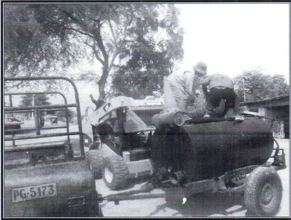
Toma N° 55: Suministro y Preparación de Emulsión Asfáltica Catiónica de Rotura Lenta Para Colocacion en Base Granular.
