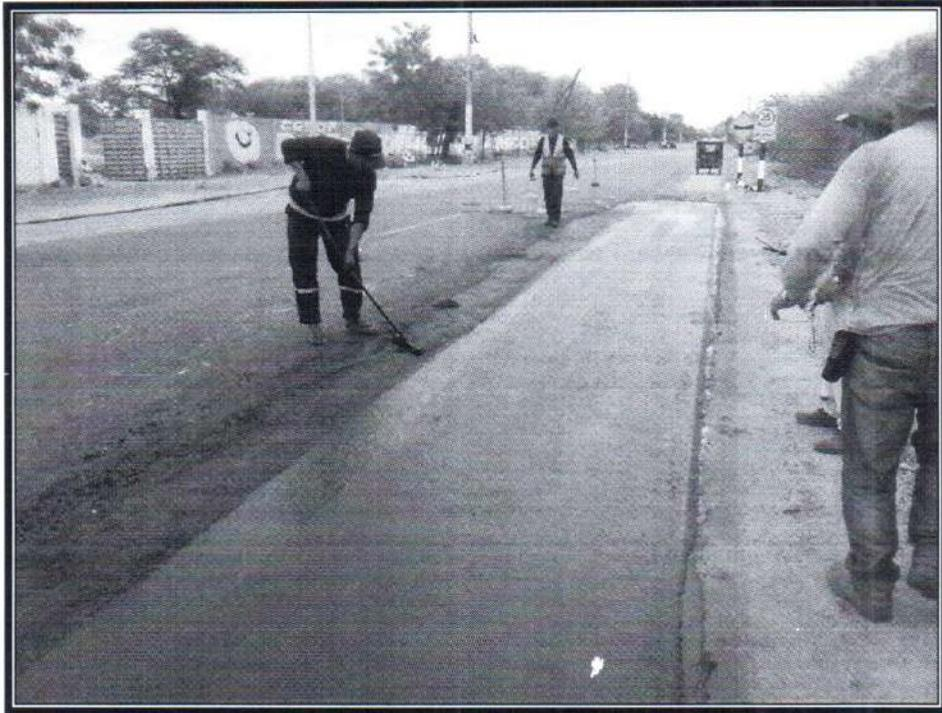
Toma N° 67: Trabajos de Empalme en colocación de Slurry Seal con pavimento existente.
