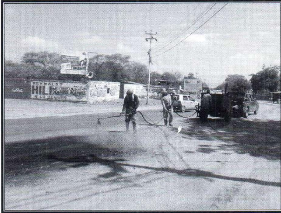
Toma N° 57: Colocación de Emulsión Asfáltica Catiónica de Rotura Lenta en Base Granular.
