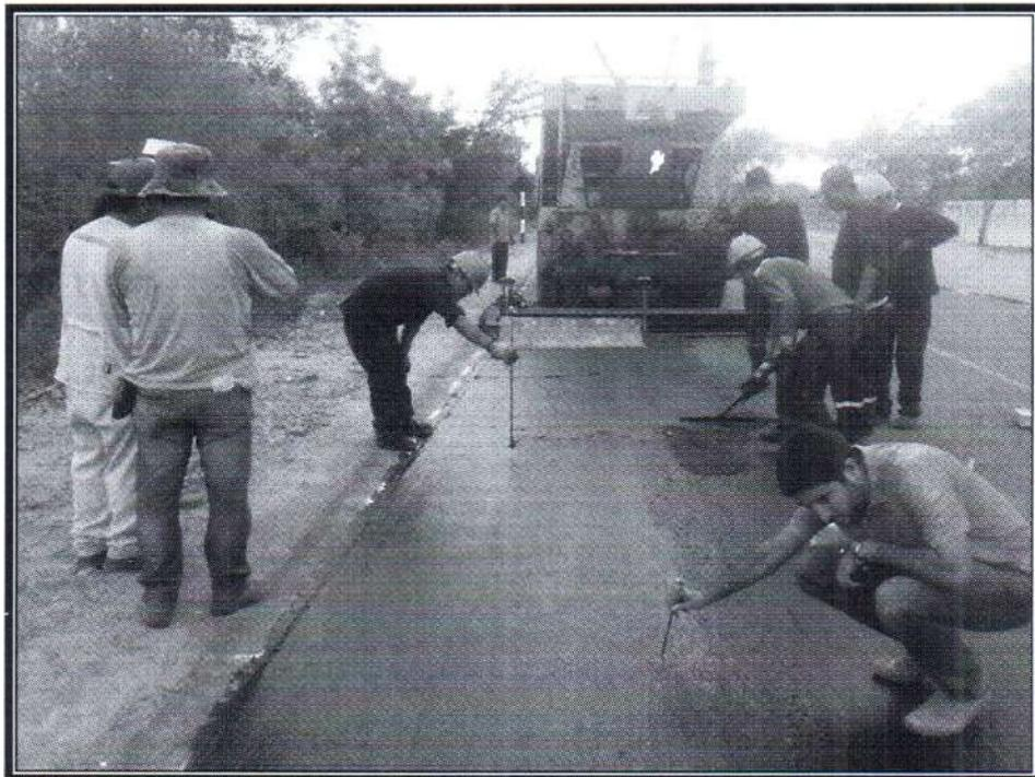
Toma N° 64: Verificación de espesor ( $e=1.5\text{cm}$ ) de Slurry Seal colocado en Berma.
