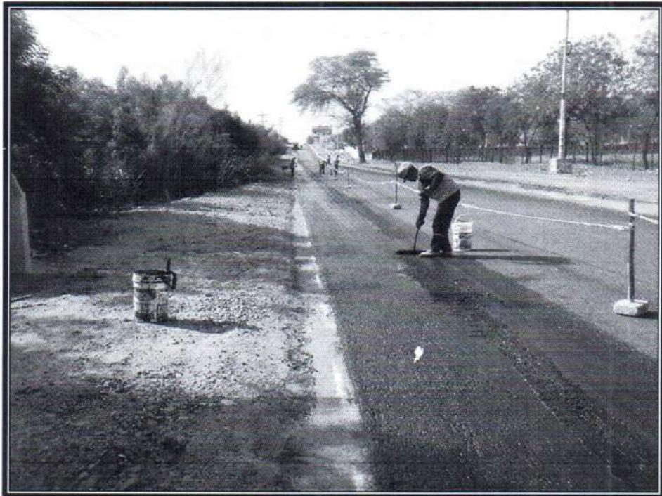
Toma N° 68: Trabajos de Empalme en colocación de Slurry Seal con pavimento existente.
