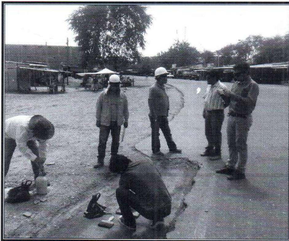
Toma N° 18: Supervisión Verificando Ensayos de Densidad de Campo en Subrasante.
