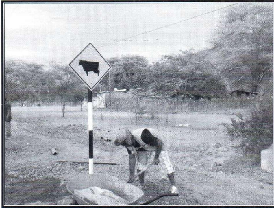
Toma N° 75: Instalación de poste de soporte y colocación de Señal Preventiva nueva.
