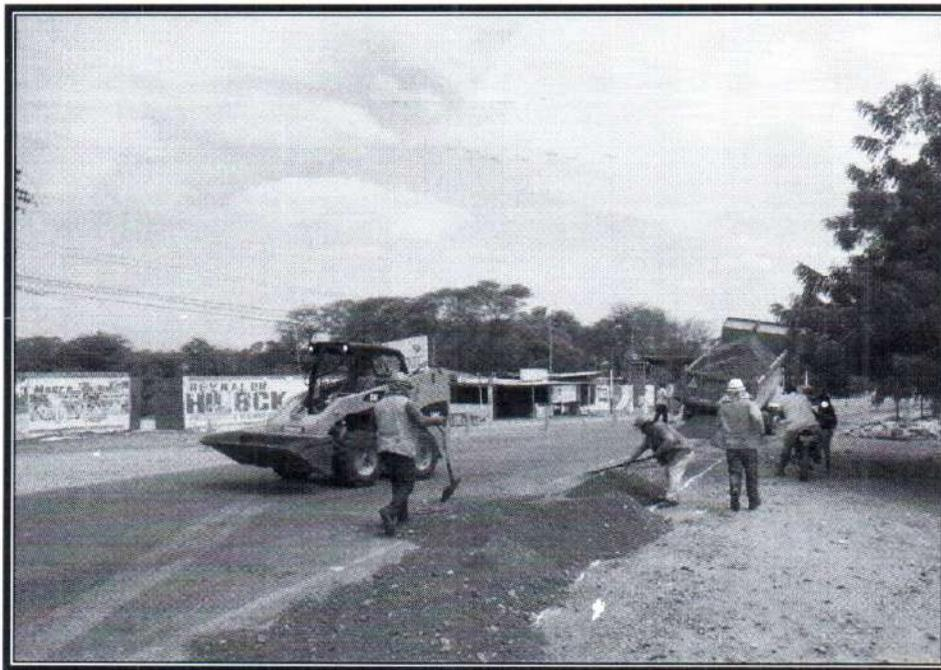
Toma N° 26: Trabajos de Conformación de Base Granular en área de Bermas.
