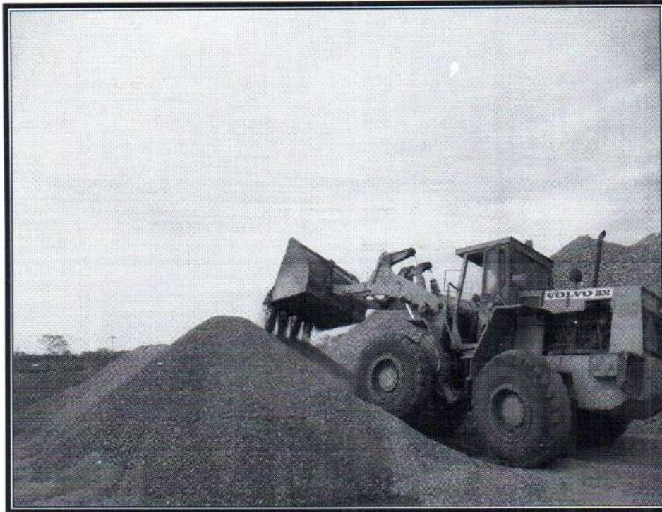
Toma N° 21: Preparación en Cantera de Material Afirmado según Diseño
