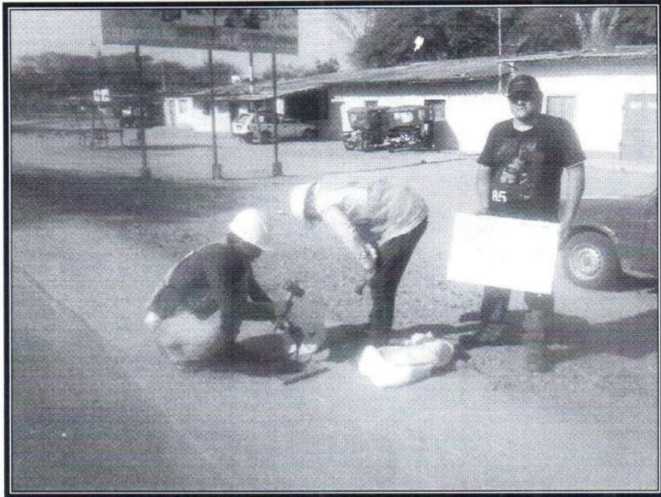
Toma N° 33: Ensayos de Densidad de Campo a Nivel de Base Granular en Bermas.
