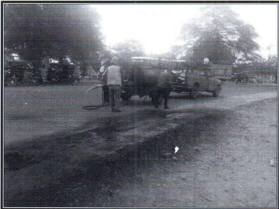
Toma N° 56: Colocación de Emulsión Asfáltica Catiónica de Rotura Lenta en Base Granular.
