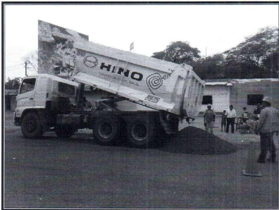
Toma N° 24: Suministro y Colocación de Material Granular en bermas de margen Derecho
