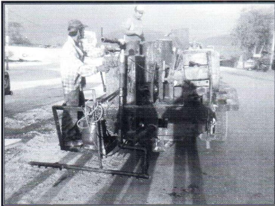
Toma N° 58: Colocación de Emulsión Asfáltica Catiónica de Rotura Lenta en Base Granular
