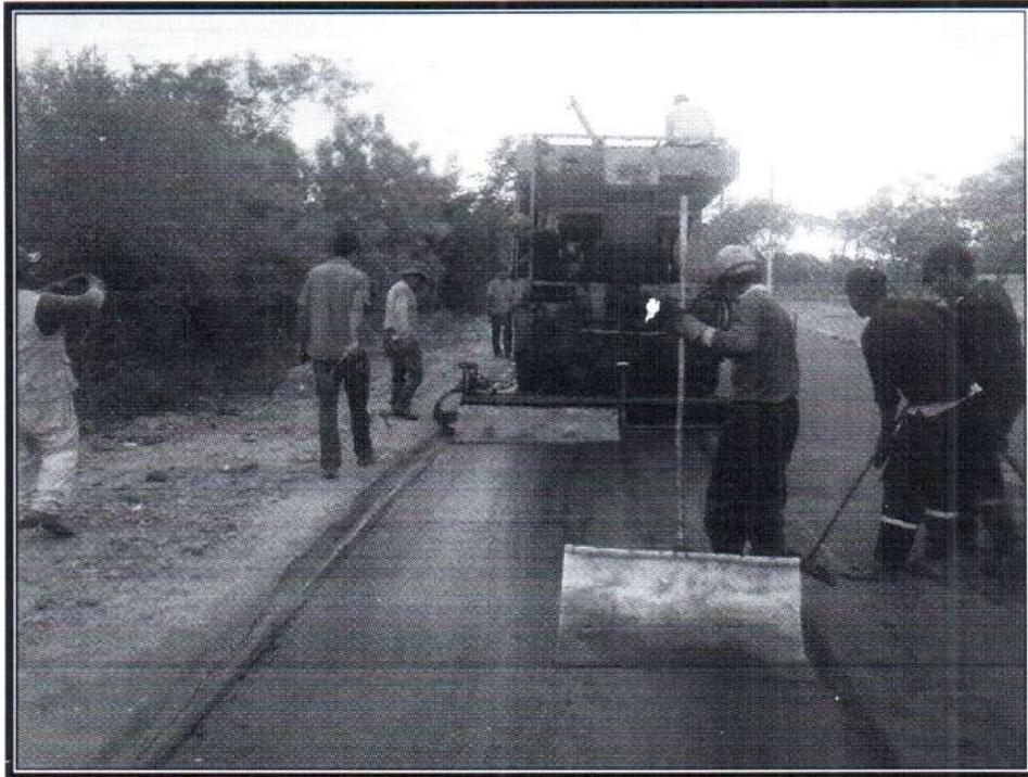
Toma N° 63: Colocación de Slurry Seal en Berma con Micropavimentadora.
