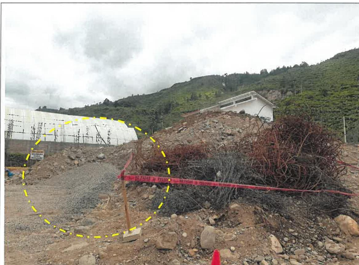
IMG. N°04.- Se evidencia que los agregados no se manejan como materiales independientes, generando contaminación con el desmote producido por la ejecución natural de la obra, pudiendo modificar su uniformidad y características.
