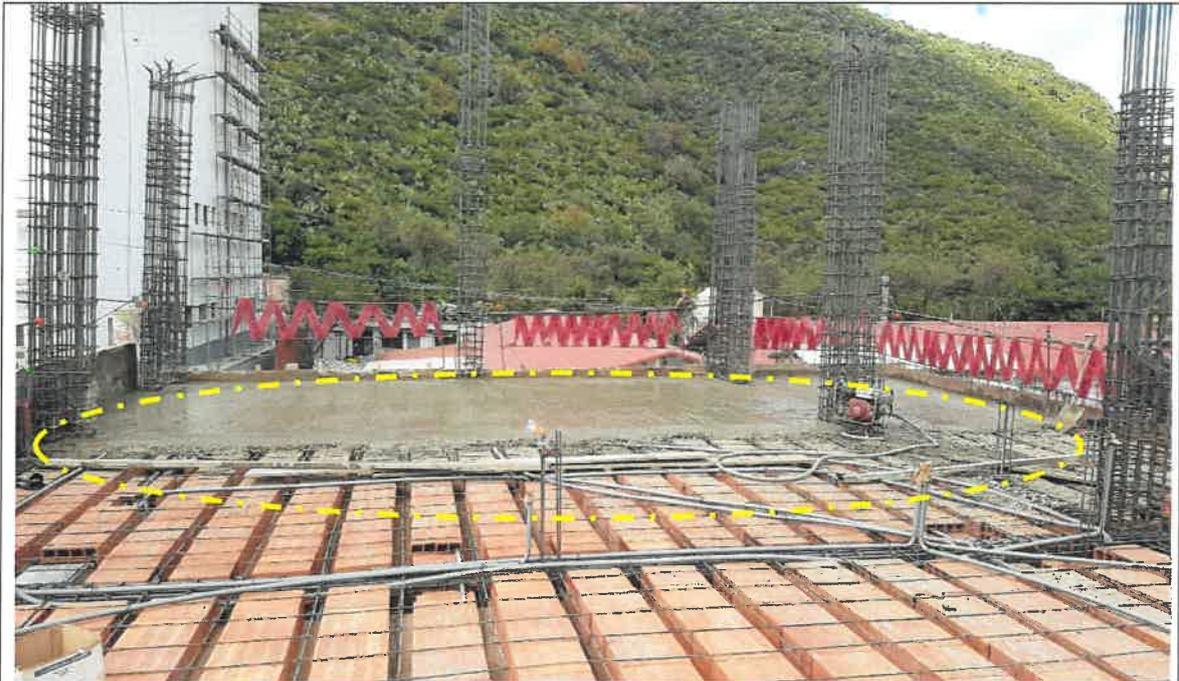
IMG. N°06.- Vaciado en obra. – Se evidencia que el proceso de vaciado se efectúa sin la continuidad de la loza aligerada lo que originaría que la disposición del concreto sea depositada sobre otro que ya haya endurecido parcialmente o contaminado con materiales extraños, lo que podría derivar en juntas o planos de vaciado dentro de la sección.
