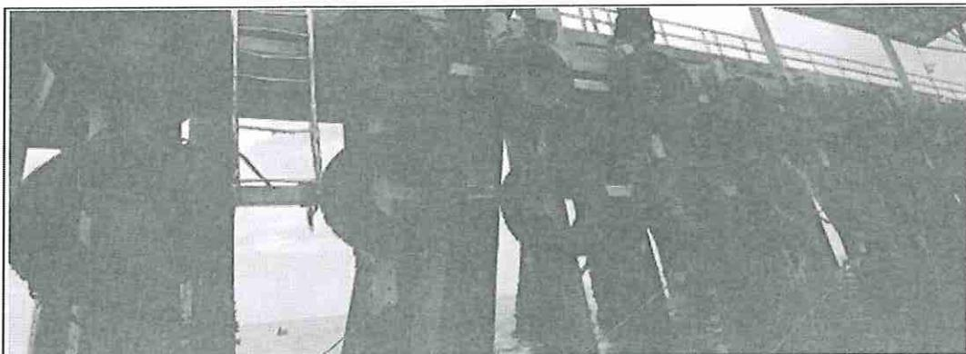
Fig. N°01.- Defensa existente de la Plataforma Baja-DPA San José, con tubos rectangulares incompletos con respecto al nivel del agua de mar
