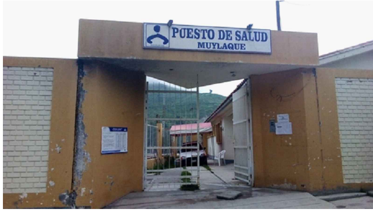
FOTOGRAFIA N°01: FACHADA PRINCIPAL DEL P.S. MUYLAQUE
