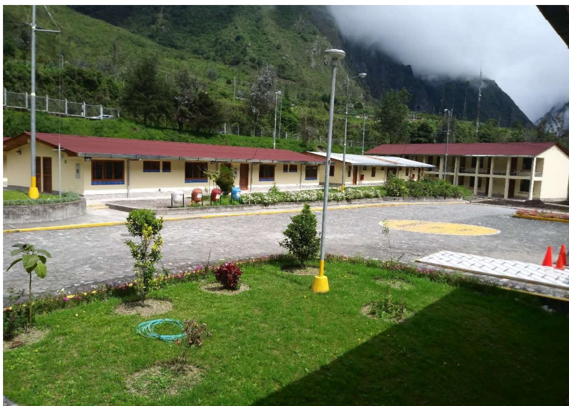
Remodelación de bloques E-1 y E-2
