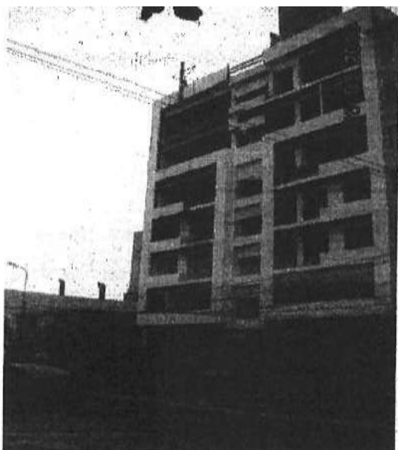
Se puede apreciar que la edificación materia del presente, se encontraba con semisótano, 7 pisos y azotea. Fecha de la foto de fachada
