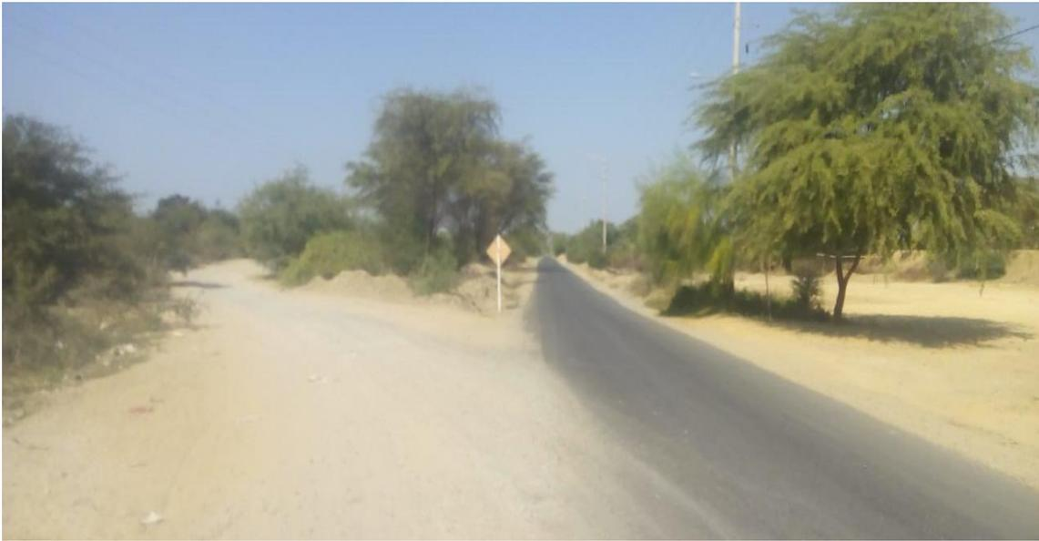
Foto 04: Encuentro de vía a intervenir con vía existente, superficie de rodadura inexistente por accionar de lluvias del FEN 2017.
