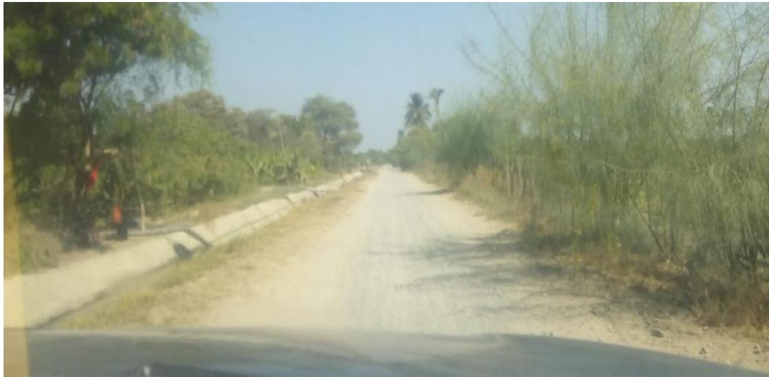
Foto 02: vía con ahuellamiento pronunciado y baches
