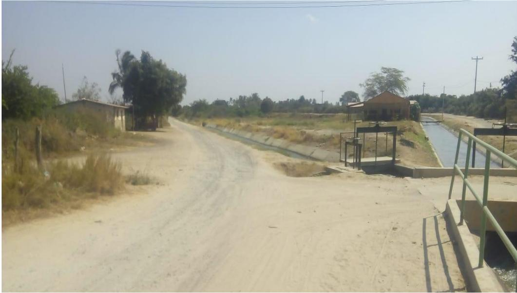
Foto 01: pérdida total de superficie de rodadura, ahuellamiento en vía
