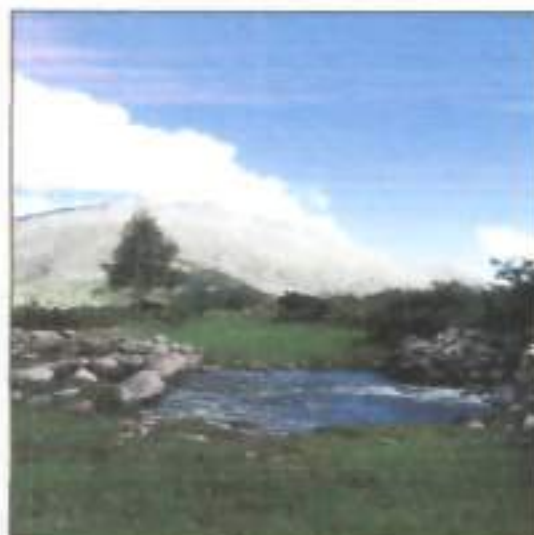
Registro Fotográfico N° 49: RIACHUELO QUE CRUZA EL CAMINO, EROSIONANDO LATERAL Y VERTICALMENTE LA SECCIÓN
