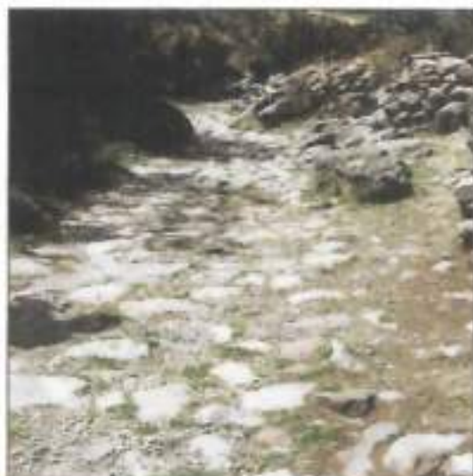
Registro Fotográfico N° 48: CALZADA DE CAMINO Y MUROS LATERALES CONSTRUIDOS CON MATERIAL DE CANTOS RODADOS DE VARIADA
