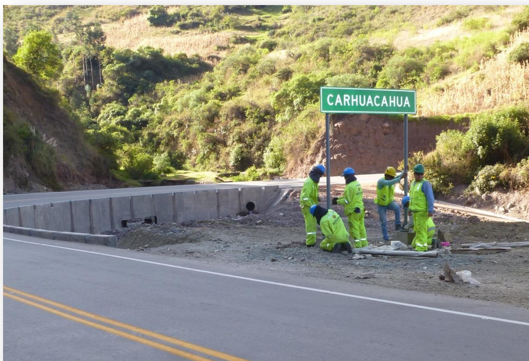
REHABILITACIÓN Y MEJORAMIENTO DE LA CARRETERA AYACUCHO – ABANCAY TRAMO: DESVÍO KISHUARA - PUENTE SAHUINTO
