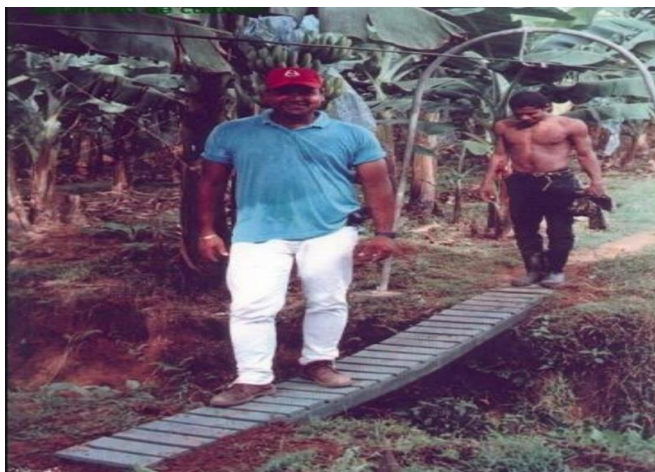
Figura 8. Imagen referencial del paso provisional con madera
