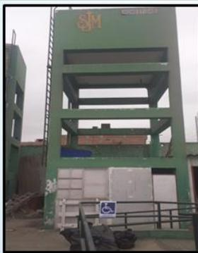
Tanque elevado con pintura en mal estado
