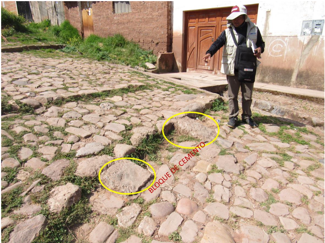
Vista donde se observa la construcción de pequeñas rampas de material de concreto, para el desplazamiento de vehículos.
