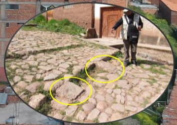
Construcción de rampas de concreto para el paso de vehículos
