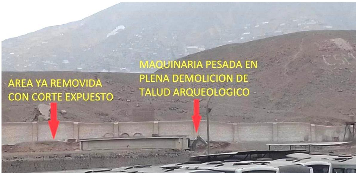
Vista de los trabajos de remoción del talud realizado con maquinaria pesada. Nótese que entre el montículo prehispánico y la maquinaria pesada hay un muro moderno de ladrillos. Este servía de perímetro conforme el plano: PP-075-INC\_DREPH/DA/SDIC-2010 WGS84. Los trabajos de remoción se encuentran al interior del nuevo perímetro propuesto para el monumento arqueológico según el plano: PP-001-MC\_DGPA/DSFL-2019 WGS84
