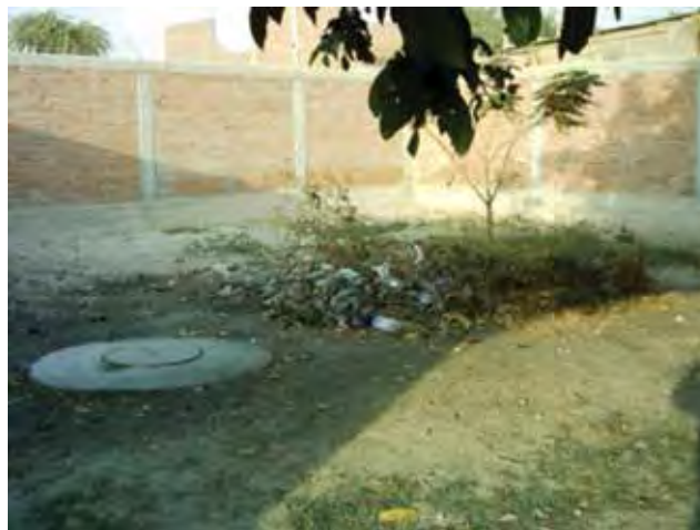
Ilustración 85: Mala práctica de disponer los sólidos extraídos de la cámara de rejillas en la misma EBAR. Fuente: Imagen del autor.
