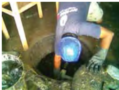
Ilustración 63: Se aprecia que introduce su mano al interior del buzón. Fuente: Imagen del autor
