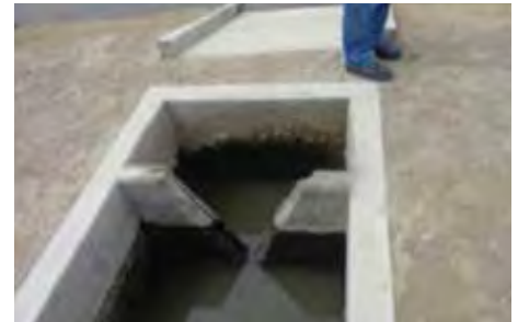
Ilustración 102: Vertedero triangular de PTAR Aypate. Fuente: Imagen del autor.
