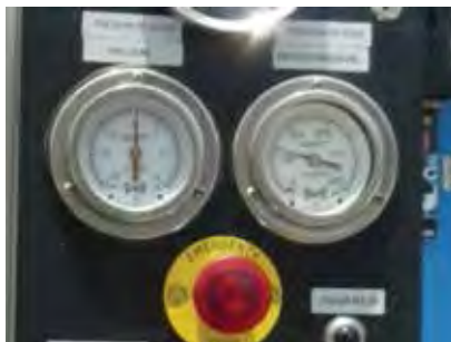
Ilustración 108: Vacuómetro a la izquierda del panel de un equipo hidrojet, usado para la bomba de succión. A la derecha, manómetro para la bomba de agua (manguera a presión). Fuente: Imagen del autor.
