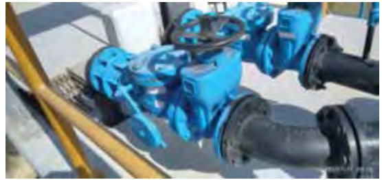
Ilustración 55: Válvula check con contrapeso. Fuente: Imagen del autor.
