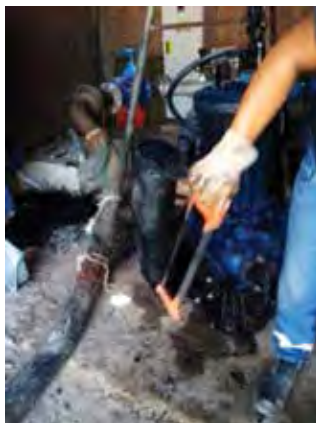
Ilustración 74: La presión registraba valores anómalos, fue necesario desmontar la bomba sumergible.
