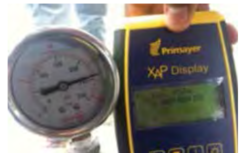
Ilustración 112: Medición de presión con manómetro convencional (PSI) y logger de presión (mca). Fuente: Imagen del autor.
