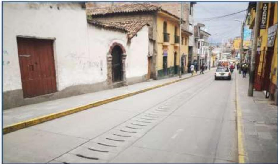
*“Esta obra se ejecutó en la ciudad de Ayacucho y corresponde a la construcción de las pistas y veredas del Jr. Carlos F. Vivanco en el centro histórico de la ciudad de Ayacucho, la misma que ha incluido la demolición de las pistas y veredas existentes, construcción de un canal de drenaje central cubierto con una losa de concreto armado con ranuras para la captación de las aguas pluviales y la correspondiente estructura hidráulica para el desfogue de las aguas pluviales en el río alameda.*
