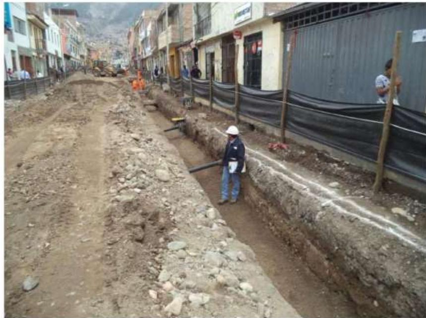
**Puede verse que el pavimento se demolió en su totalidad y fue construido nuevamente luego de las obras del canal de drenaje**
