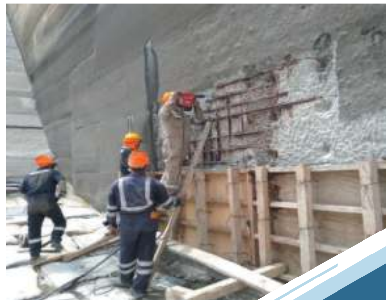
Vaciado de mortero del muro izquierdo de la poza del Barraje Fijo
