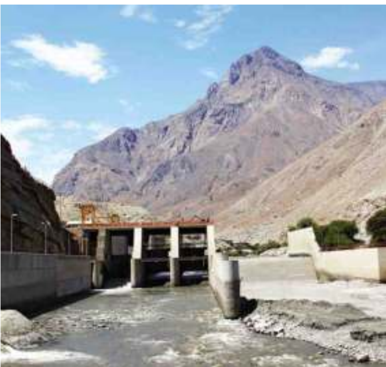
Bocatoma de captación - 412 msnm
