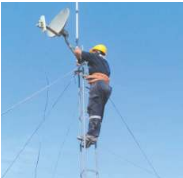
Mantenimiento de Torres y Antenas de Comunicación
