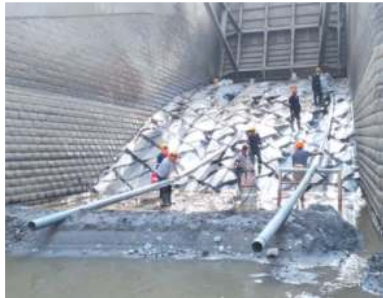
Bombeo y limpieza de las pozas del canal de limpia Barraje Móvil de Bocatoma
