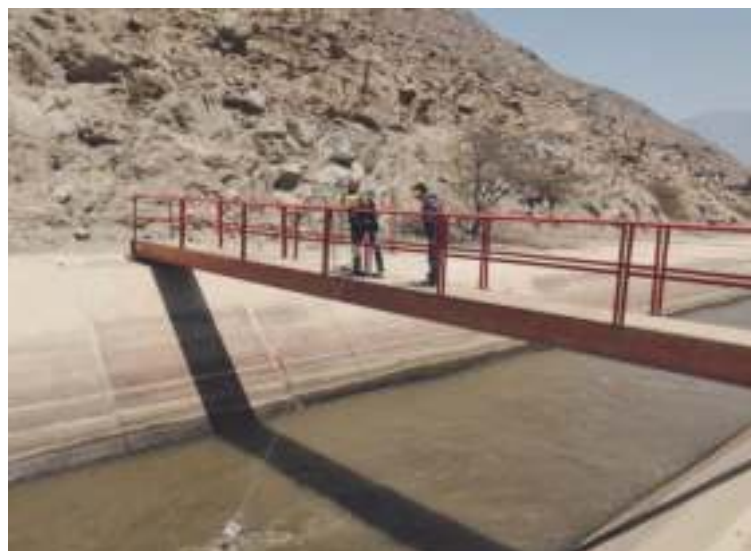
Toma de muestra de Desarenador
