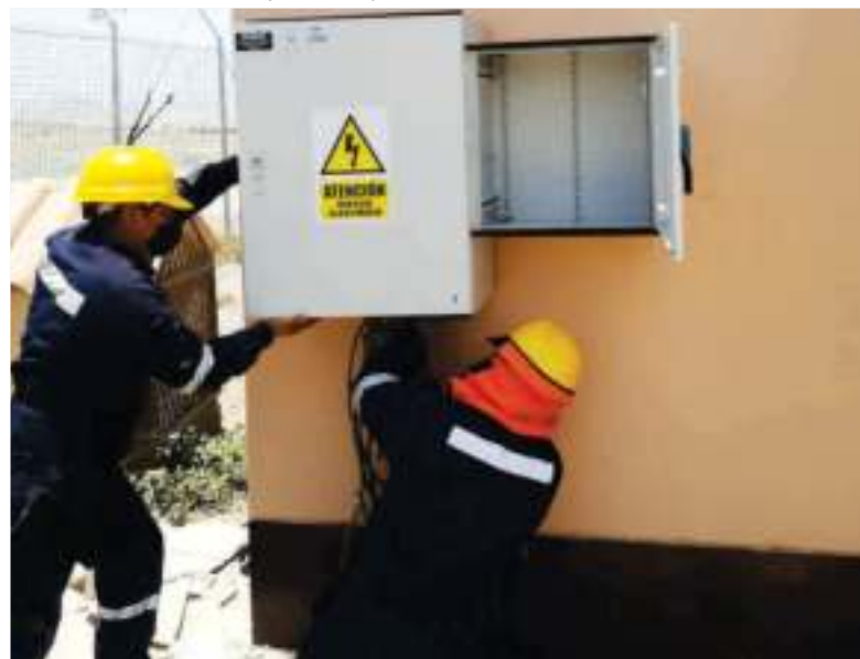
Instalación de tableros eléctricos
