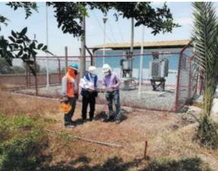
Replanteo de obra, ubicación de la subestación de transformación tipo caseta.
