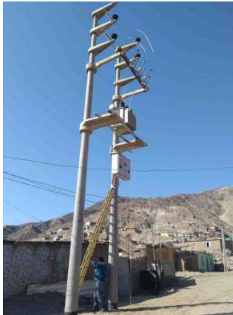
Mantenimiento de transformadores
