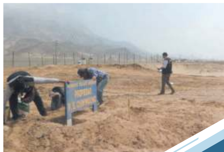
Instalación de paneles de identificación en áreas de propiedad del PECH
