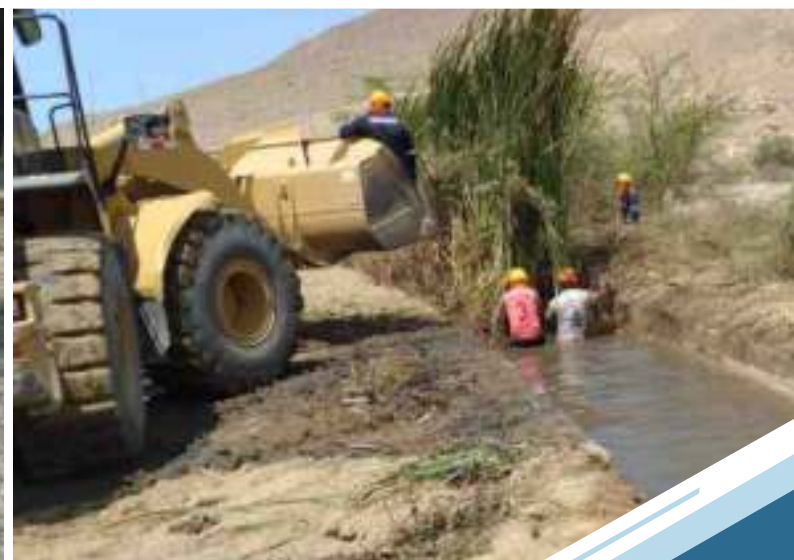
Limpieza de Canal Pampa Blanca
