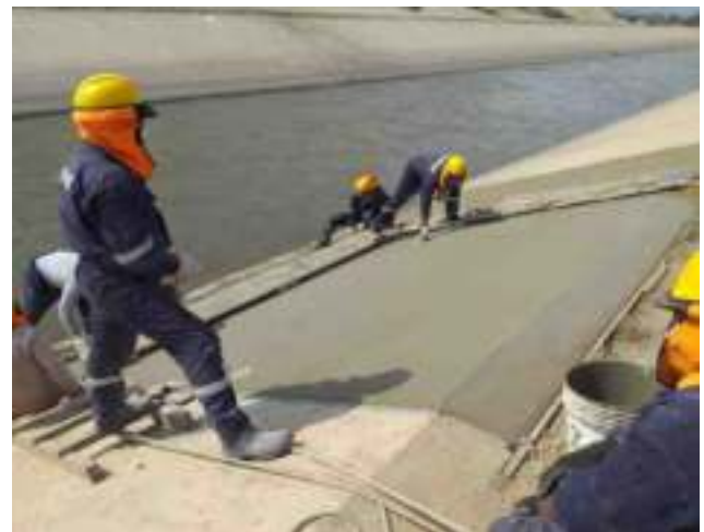
Reposición de revestimiento del Canal Madre
