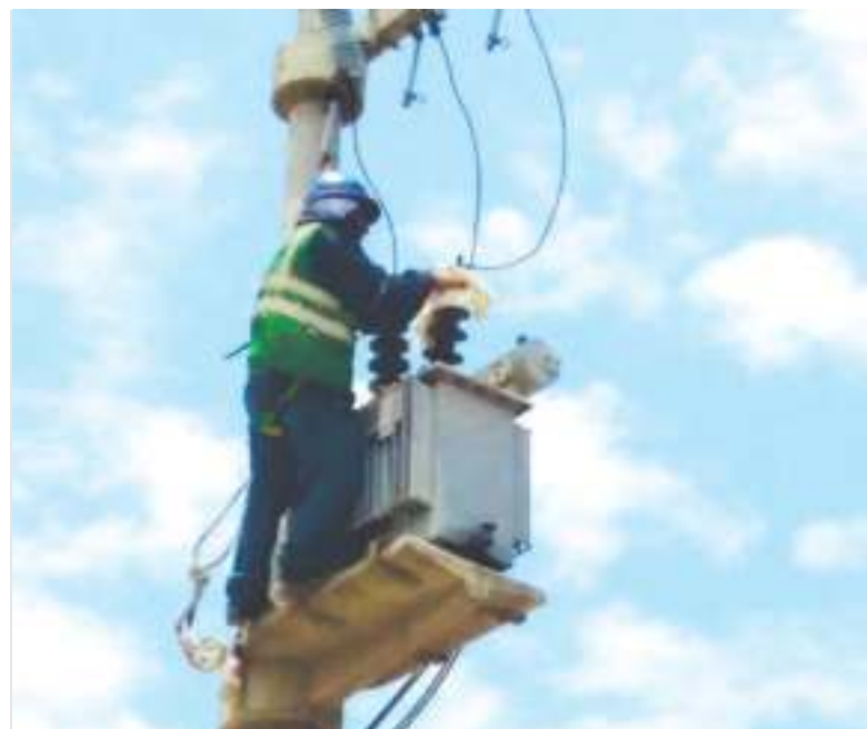
Instalación de transformadores y mantenimiento de líneas de transmisión
