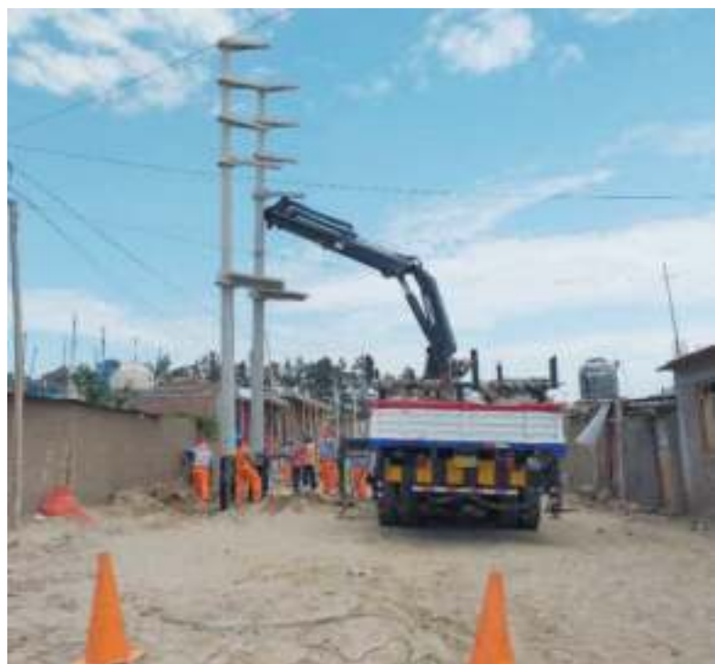
Izaje del bipostes con sus respectivas mensulas de concreto armado
