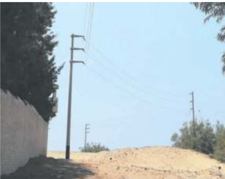
Montaje de la red eléctrica aérea, llegada a la PTAPT
