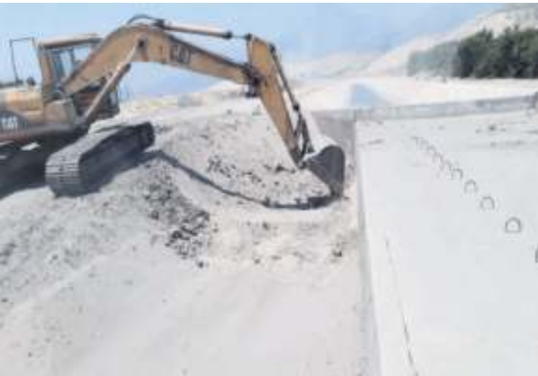
Desarenamiento de camino de servicio de Canal
