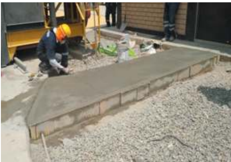
Construcción de veredas en sala de comandos de Bocatoma
