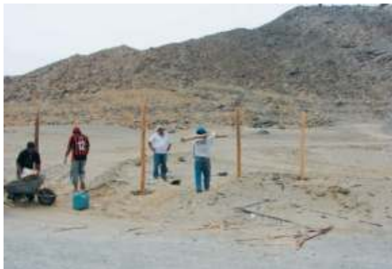
Colocación de cercos para resguardar áreas de propiedad del PECH
