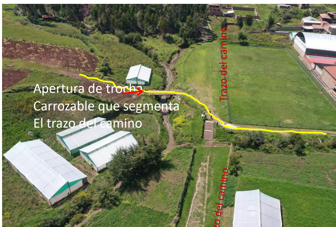
Vista del trazo del camino, la misma que ha sido afectado por la apertura reciente de trocha carrozable.
