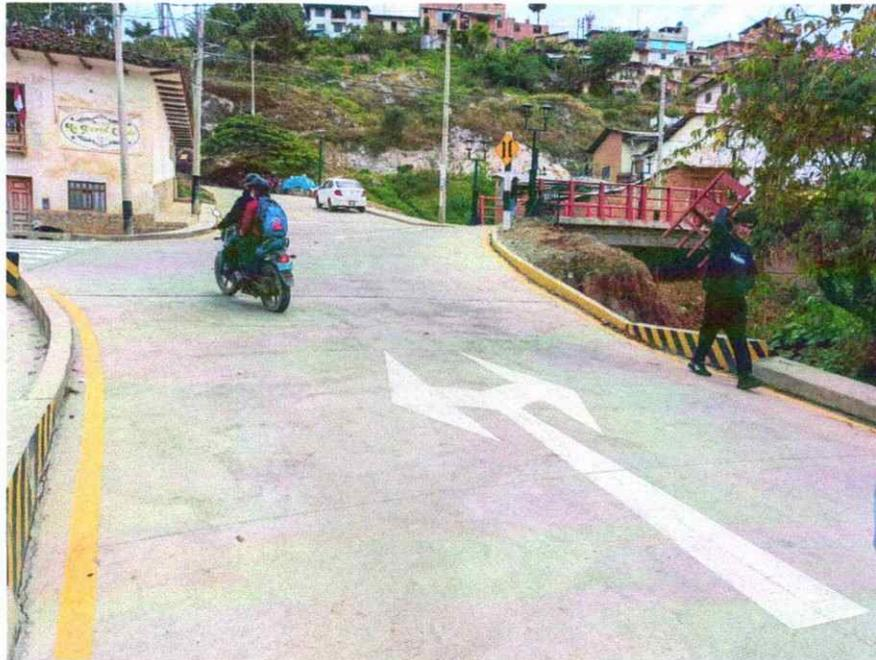
**FOTOGRAFÍA N°02:** Inexistencia de paso peatonal, corte de circulación peatonal mediante vereda.
